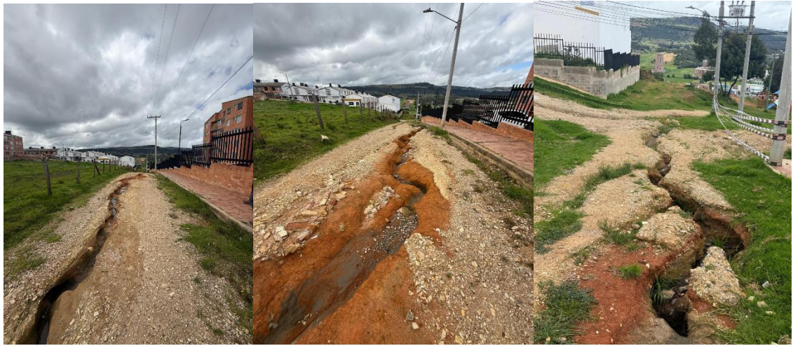
Figura 20. Tramo 4 entre Calle 54 y Cra 13.
