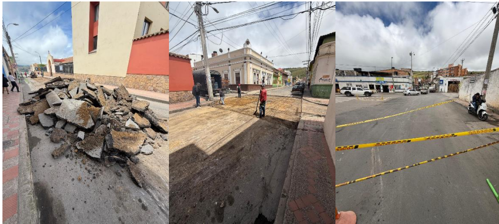
Figura 22. Inspección interventoría reparacheo calle 17 entre Cra 7 y Av. colon.
