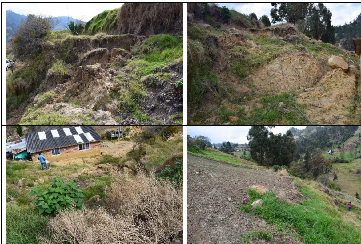
Ilustración 18. Visita vivienda afectada por desprendimiento de talud.
