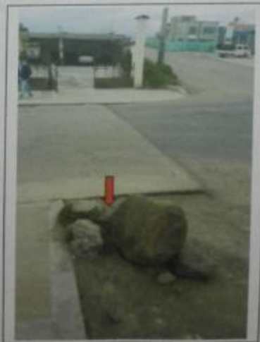
APIQUE No.7: Calle 34 – lado derecho
