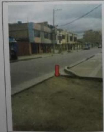
APIQUE No. 3: Calle 29 A – lado derecho
