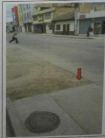
APIQUE No. 4: Calle 30 – lado derecho
