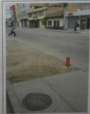
APIQUE No. 4: Calle 30 – lado derecho
