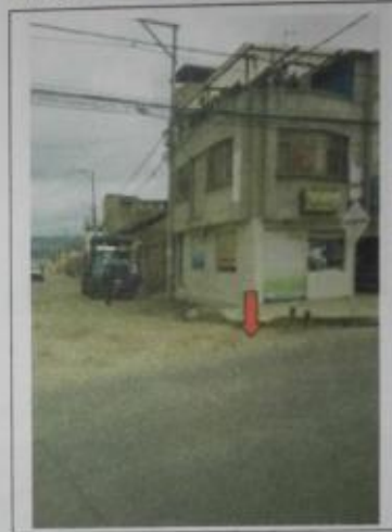
APIQUE No. 2: Calle 28 – lado izquierdo
