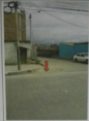
APIQUE No. 5: Calle 31 – lado izquierdo
