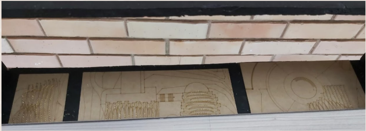
Figura 49. Vista inferior de Catenarias, Autoria propia
