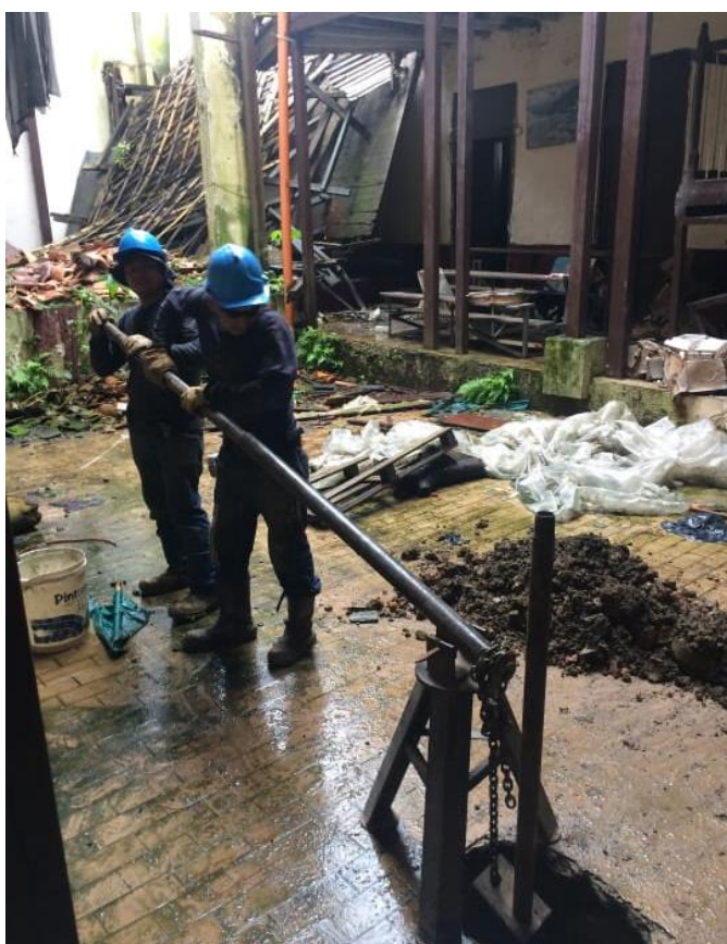
Figura 6 Perforación Geotécnica de Tipo Manual. Fuente: Elaboración Propia.
