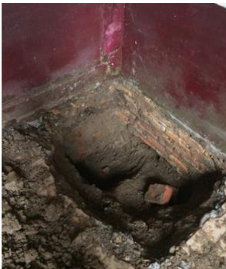
Figura 7 Apique de Exploración. Cimentación Actual Existente. Fuente: Tibocor Ltda.
