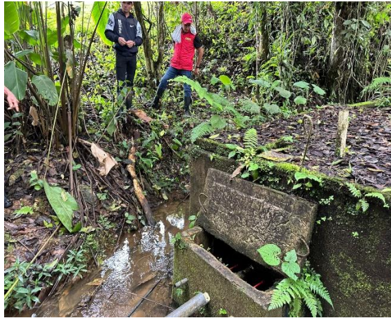
Figura 33. Visita en campo a estructuras públicas del municipio
