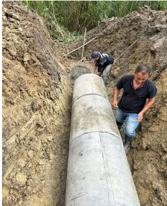
Figura 18. Implementación de estructura para alcantarillado
