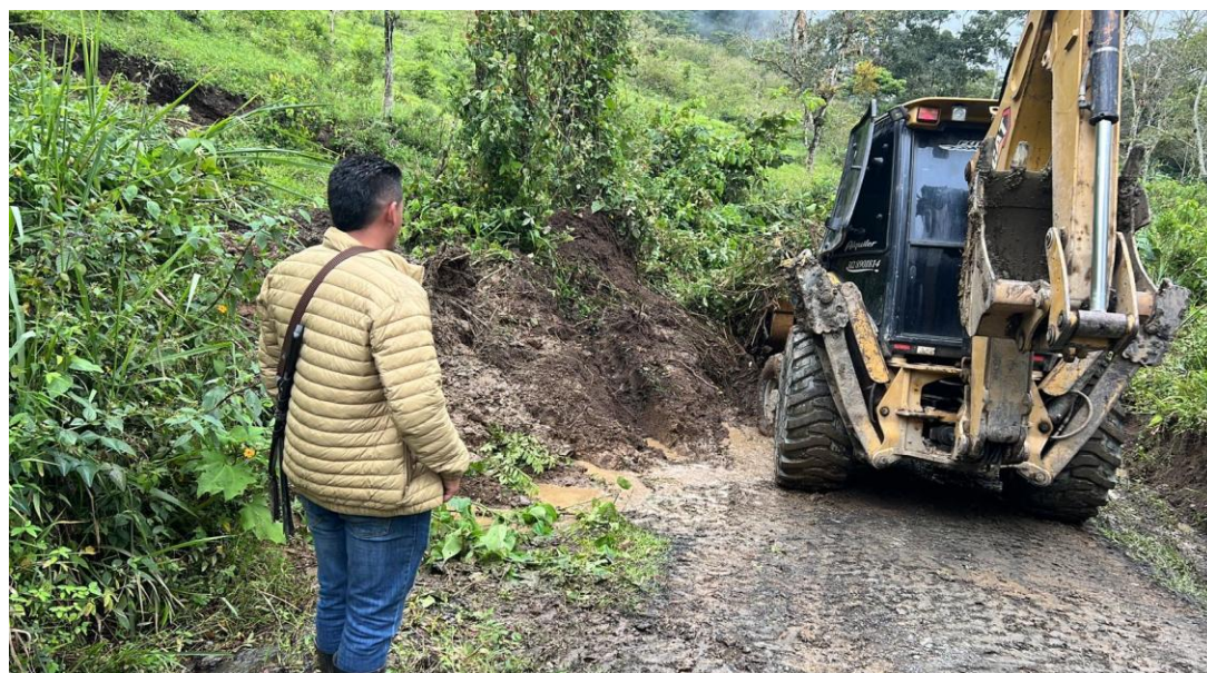
Figura 7. Visita de campo para obras de infraestructura pública, construcción y/o mejoramientos de vivienda
