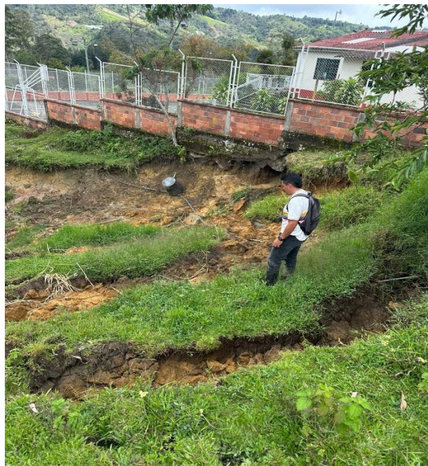
Figura 12. Visita de campo a terreno afectado por deslizamiento
