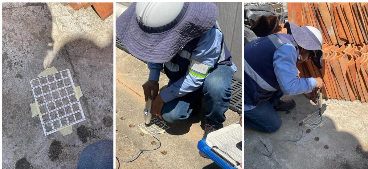
Figuras 74, 75 y 76: Procedimiento de Esclerometría– Patio Principal - Casa de Gobierno de Salgar - Antioquia
