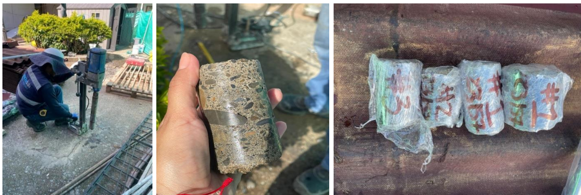
Figuras 63, 64 y 65: Extracción de núcleos de concreto 3'' in situ – Patio Principal - Casa de Gobierno de Salgar - Antioquia
