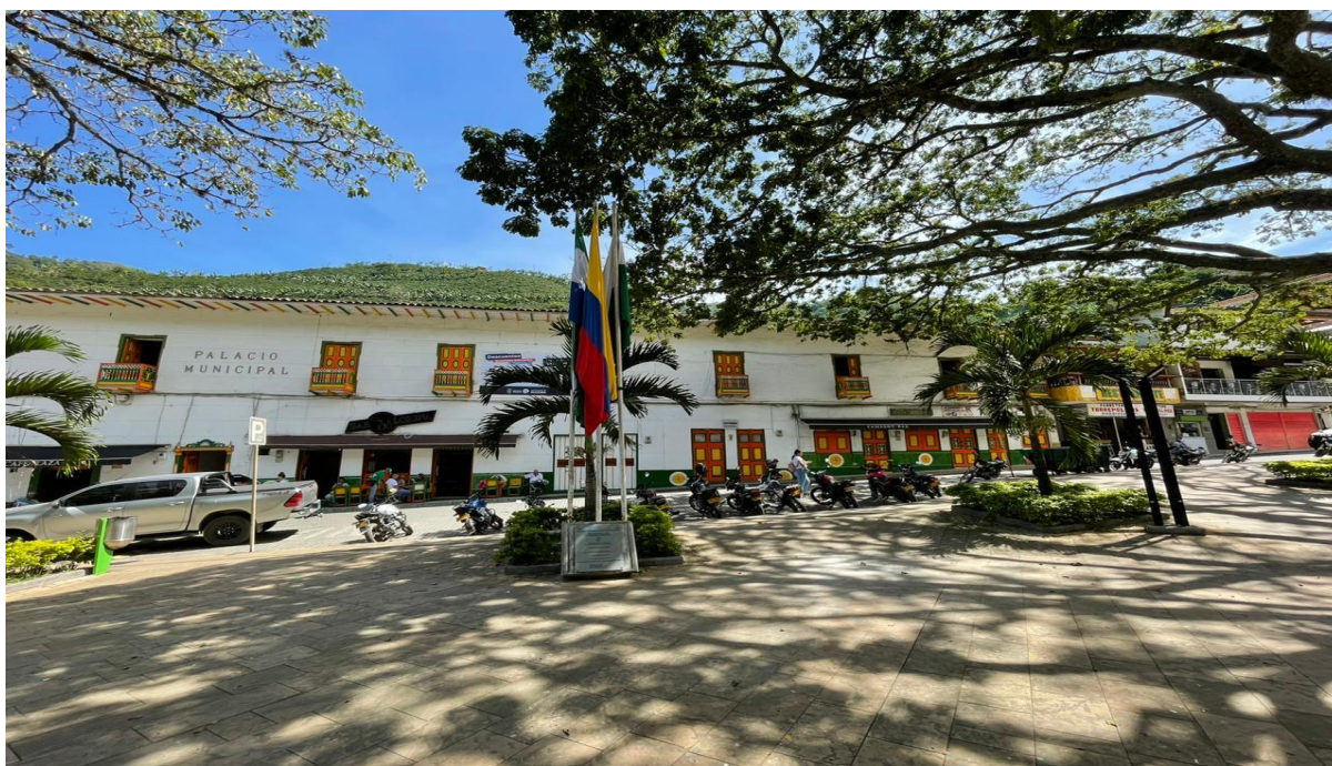
Figura 10: Fachada sobre la calle 29 - Casa de Gobierno – Salgar, Antioquia
