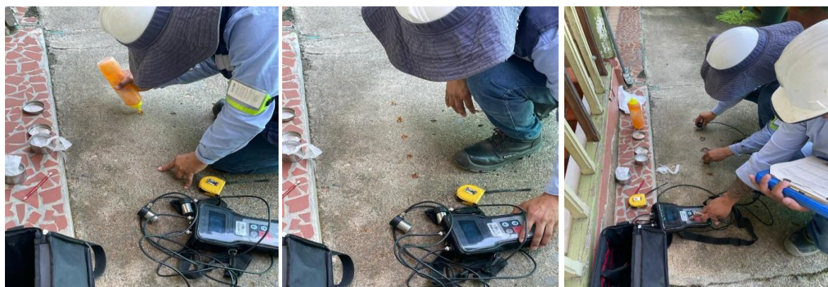
Figuras 80, 81 y 82: Procedimiento Ensayo de Ultrasonido de losa de concreto – Patio Principal - Casa de Gobierno de Salgar - Antioquia
