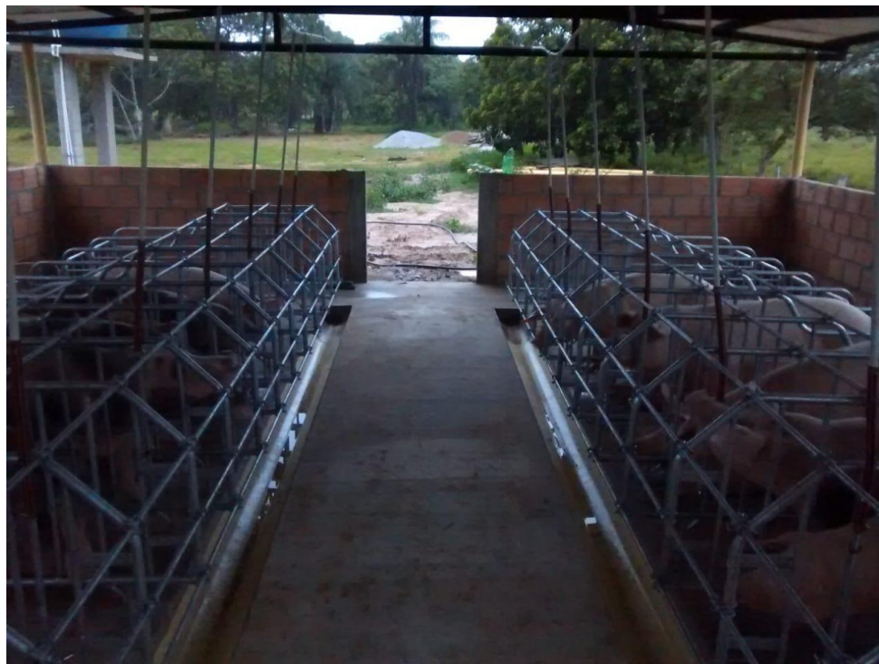
Figura 31. Módulo gestacion terminado. (QUALITY PORK S.A.S, 2018).
