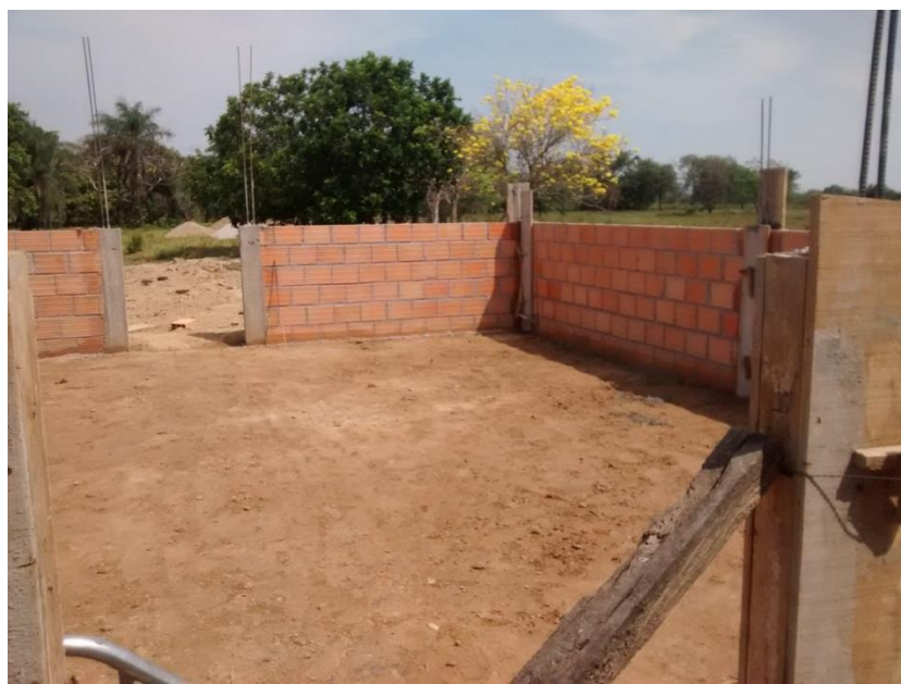
Figura 24. Levantamiento de muros. (QUALITY PORK S.A.S, 2018).
