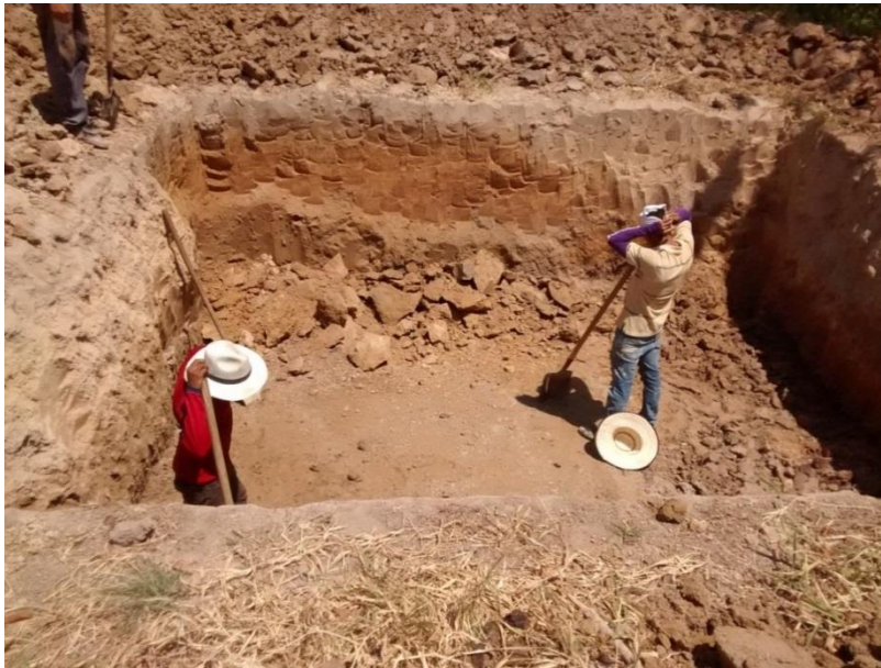
Figura 22. Excavación para posteriormente hacer el relleno. (QUALITY PORK S.A.S, 2018).
