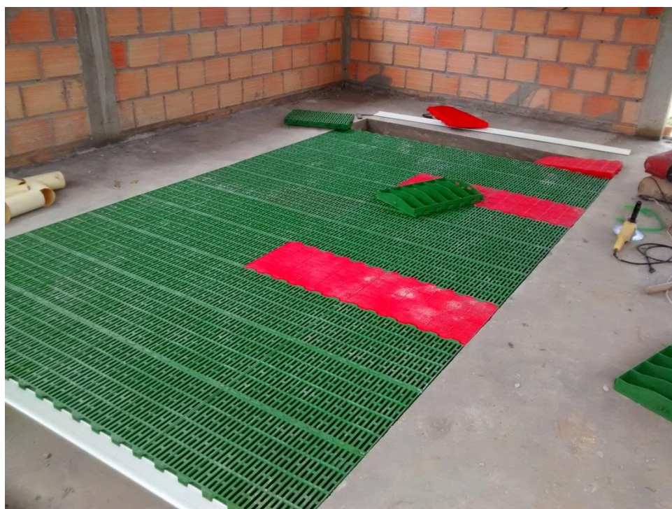
Figura 28. Instalación de piso plástico. (QUALITY PORK S.A.S, 2018).
