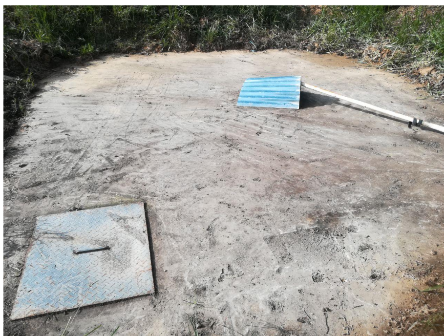
Figura 30. Tanque estercolero terminado. (QUALITY PORK S.A.S, 2018).
