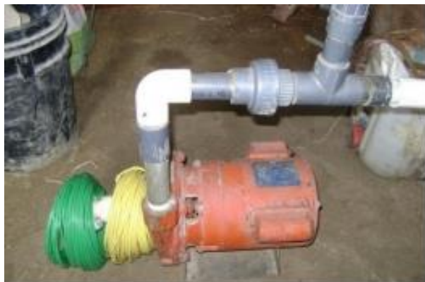
Figura 57. Electro bomba de succión fosas. (QUALITY PORK S.A.S, 2018).
