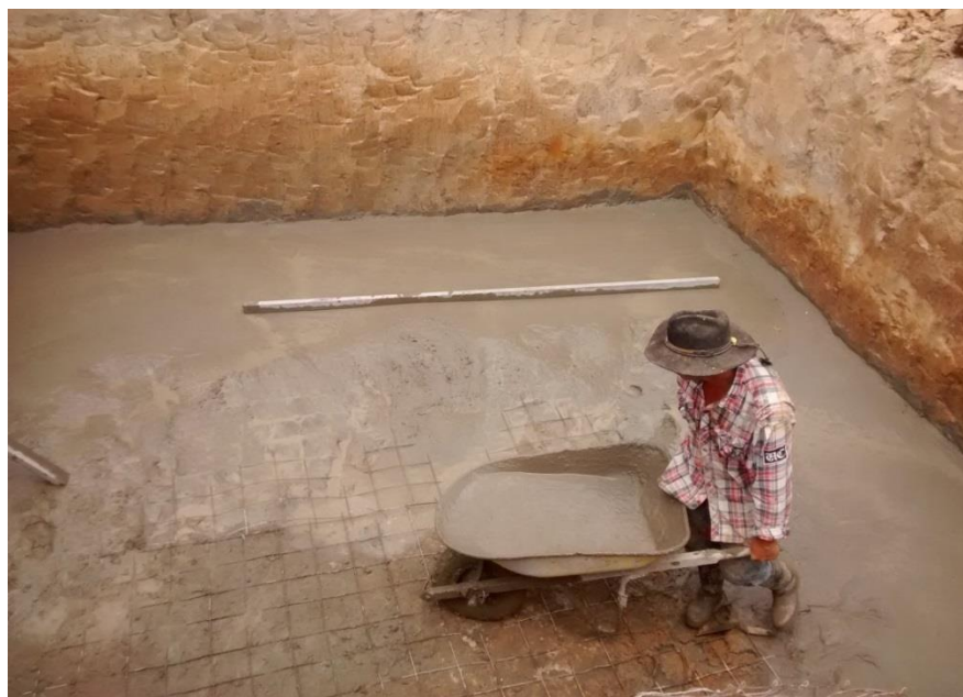
Figura 23. Base terminada. (QUALITY PORK S.A.S, 2018).
