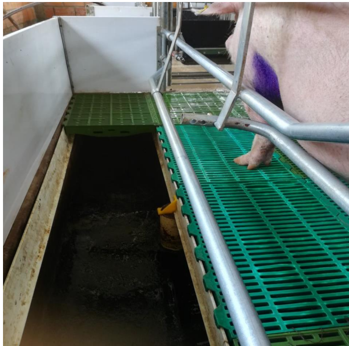
Figura 42. Fosa húmeda a donde el operario arroja las excretas. (QUALITY PORK S.A.S, 2018).
