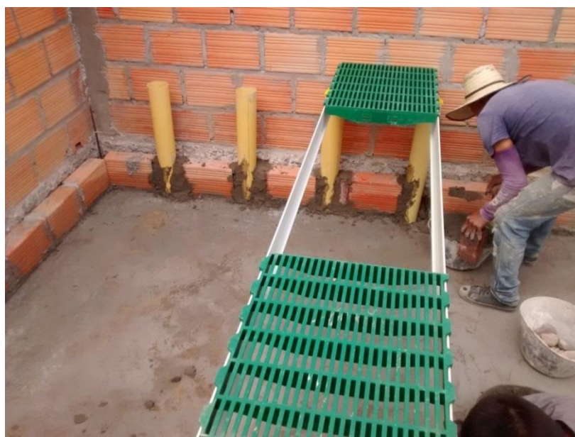
Figura 26. Adecuación de cunas elevadas módulo de pre cebo. (QUALITY PORK S.A.S, 2018).
