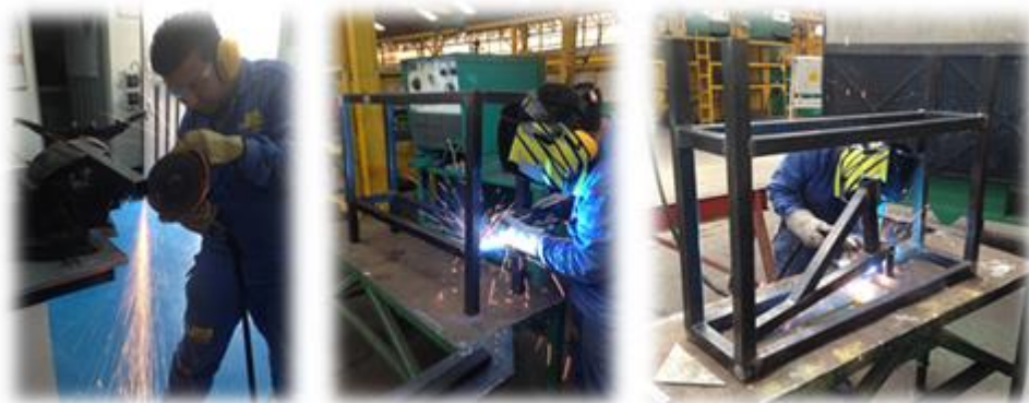
Figura 41. Evolución en la construcción del marco estructural
