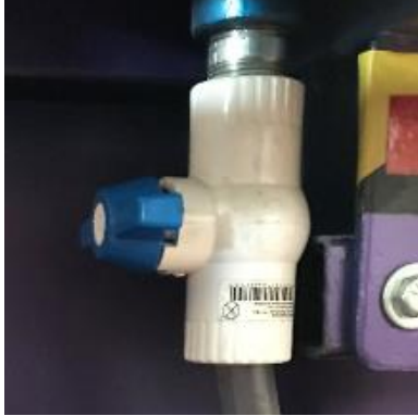
imagen 8. Valvula de paso instalada
