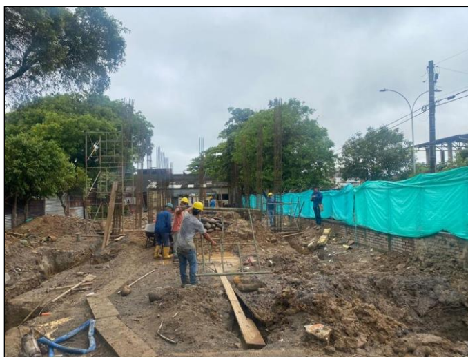
Figura 22. Traslado de zapatas y vigas de amarre.
