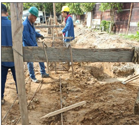
Figura 41. Armado del refuerzo de la viga.
