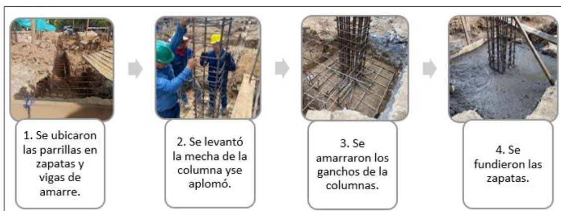
Figura 45. Fundición de zapatas
