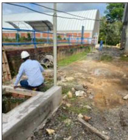
Figura 3. Verificación de medidas en la Villa olímpica.
