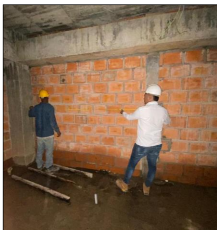
Figura 4. Verificación de medidas en la Villa olímpica.
