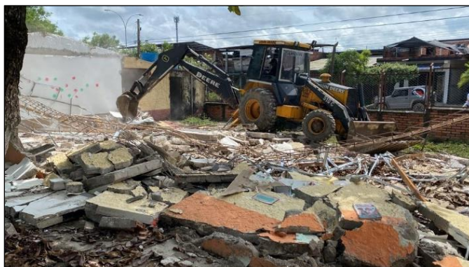
Figura 19. Demolición de las aulas.
