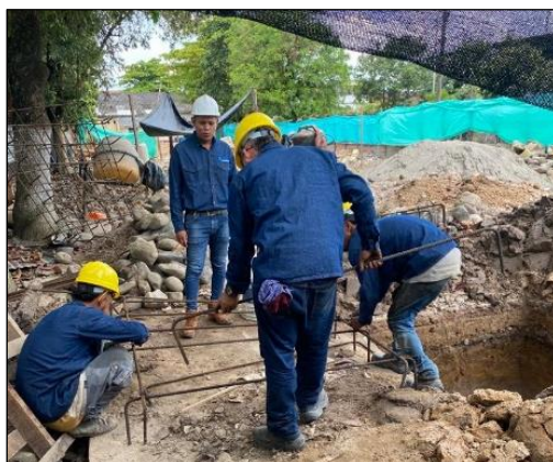
Figura 43. Armado de parrillas por el personal.
