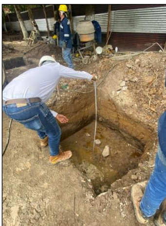
Figura 35. Verificación de la profundidad.
