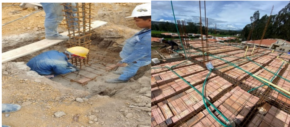
Figura 6: Armado de refuerzo estructural “Acero”
