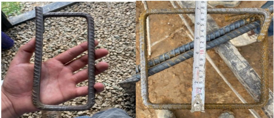
Figura 25: Control de estribos sin gancho a 135^\circ .
