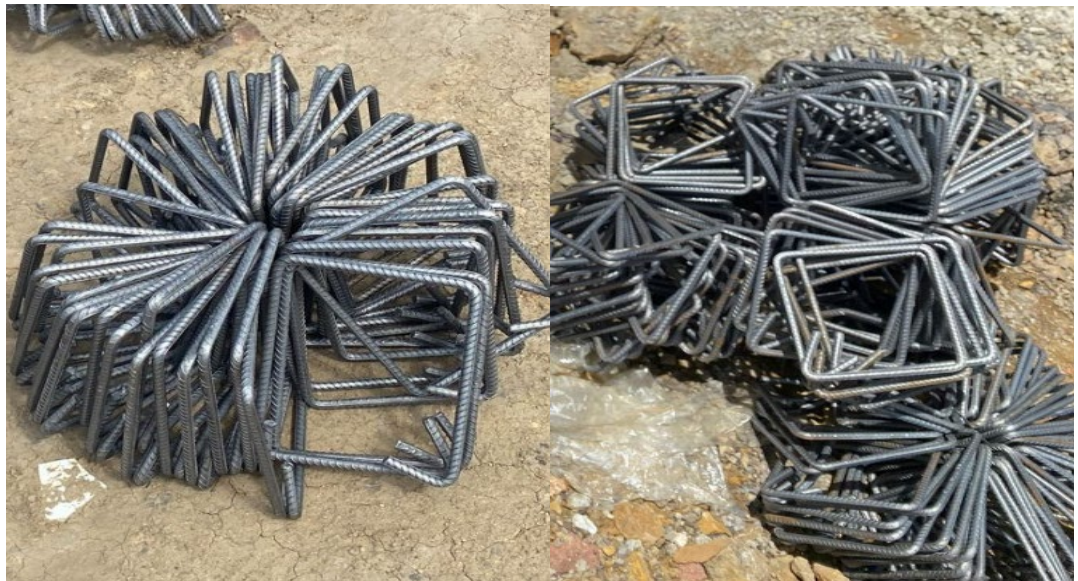
Figura 26: Control de estribos con gancho a 135^\circ .
