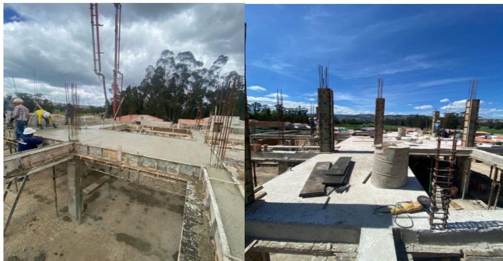
Figura 14: Fundición de elementos estructurales CASA N°25
