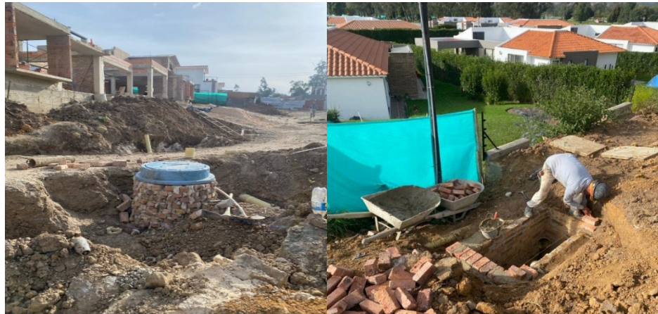
Figura 4: Alcantarillado "TIMANA VERDE II"
