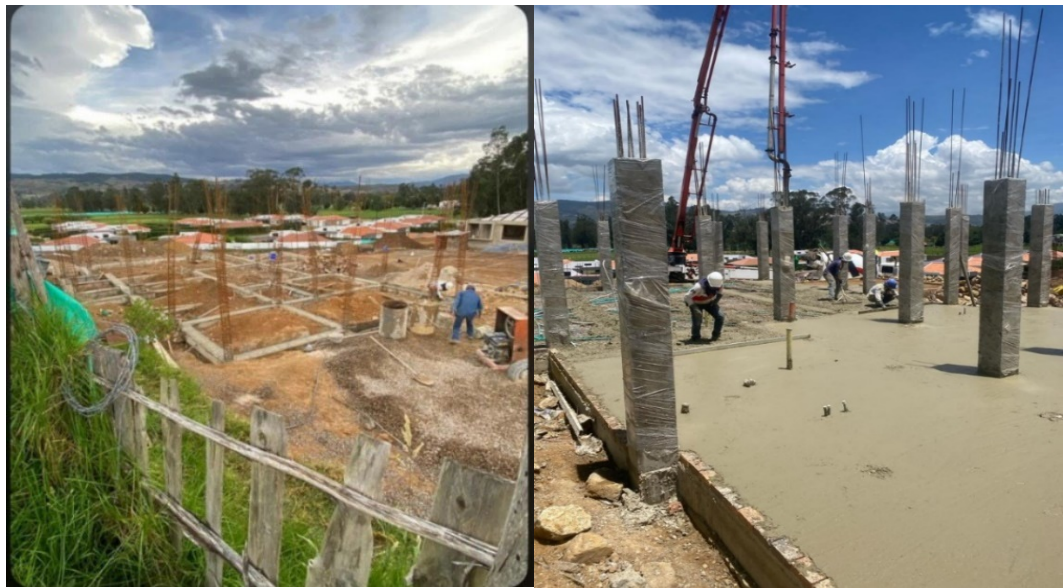
Figura 15: Fundición de elementos estructurales CASA N°24.
