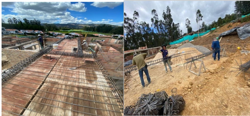
Figura 7: Refuerzo transversal y longitudinal en elementos estructurales.
