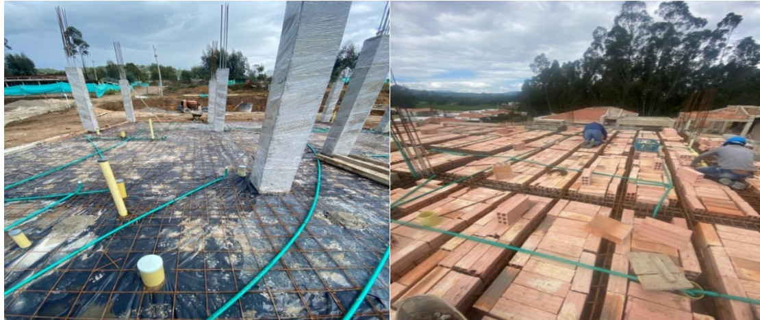
Figura 9: Verificación de instalaciones hidrosanitarias, pluviales, hidráulicas y electricas.
