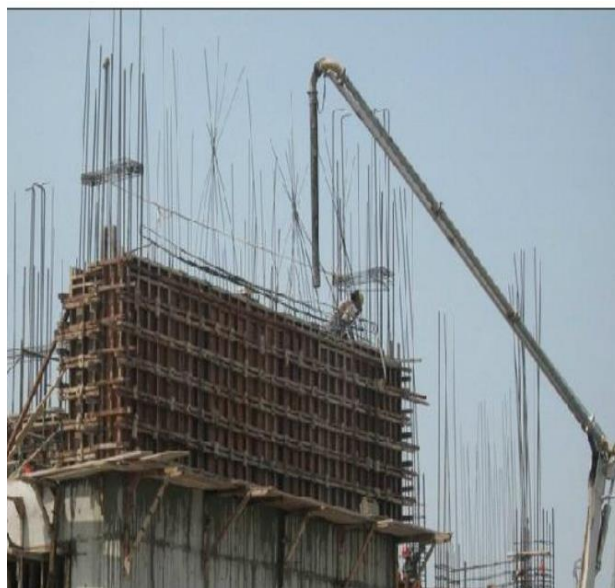
Ilustración 13-8 Refuerzo de muros
