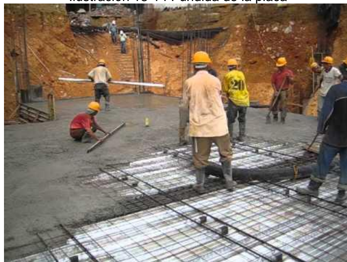
Ilustración 13-14 Fundida de la placa
