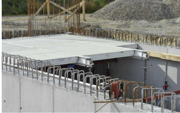
Ilustración 13-15 Desencofrado de la placa
