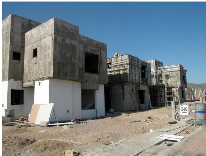
Ilustración 13-12 desencofrado de muros
