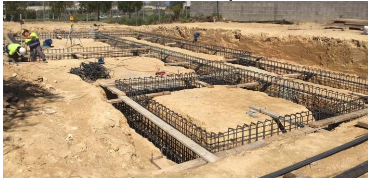
Ilustración 13-2 Excavación y Cimentación
