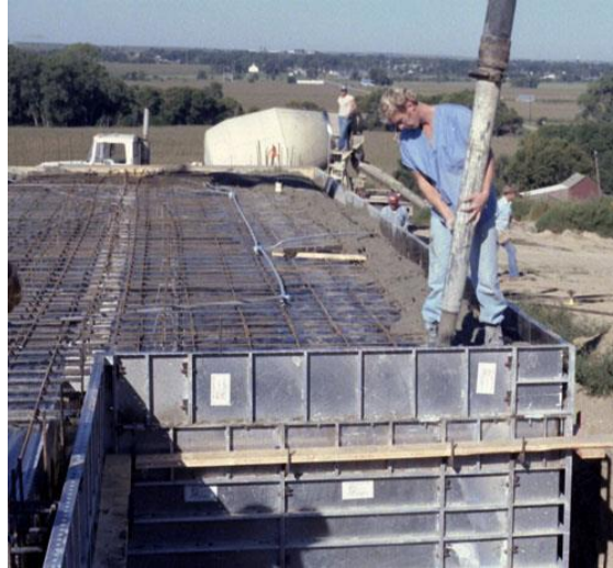
Ilustración 13-11 Concreto aplicado
