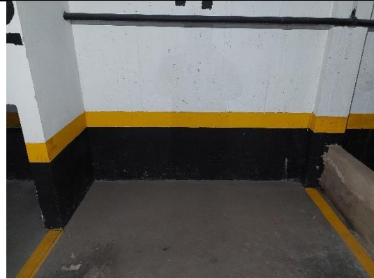
Fotografía 32. Muro costado occidental. (04 octubre 2023).
