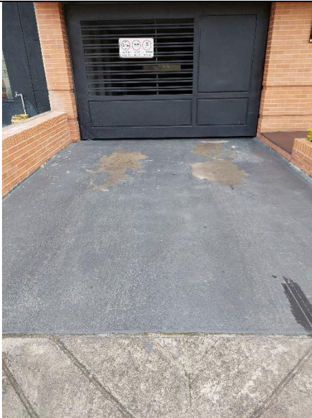
Fotografía 21. Acceso vehicular al edificio.
