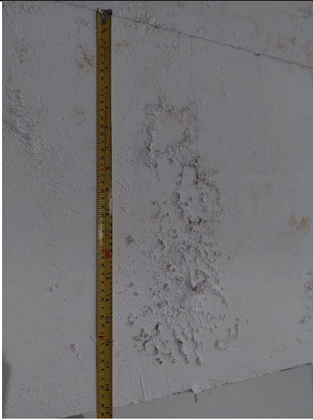
Fotografía 41. Detalle de viga estructural con lesión debida a humedad.
