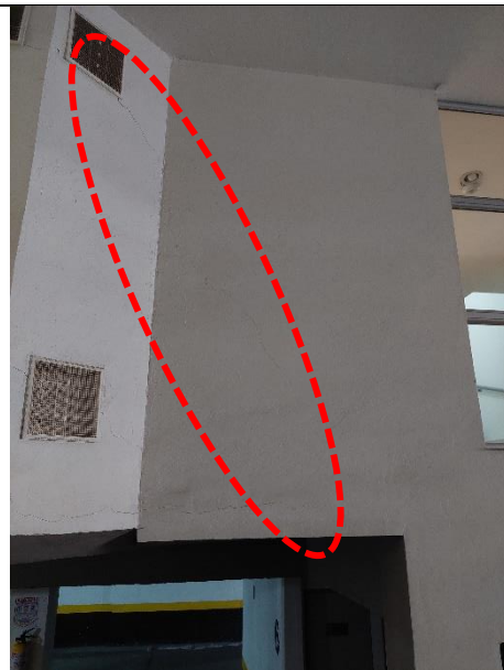
Fotografía 14. Continuidad de fisura hasta ducto de ventilación de cocineta.
