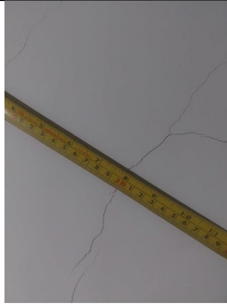
Fotografía 46. Medición de fisuras diagonales en muro divisorio ancho 0.2 mm.
