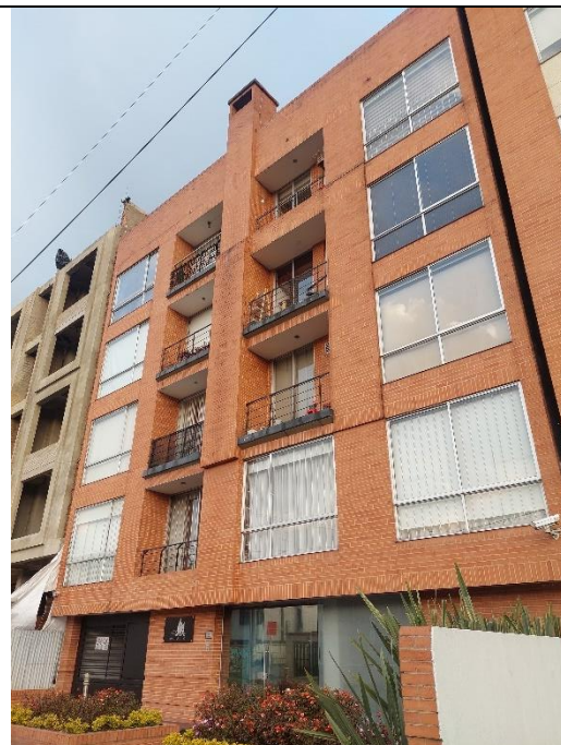
Fotografía 6. Vista general de fachada.
