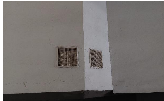
Fotografía 14. Continuidad de fisura hasta ducto de ventilación de cocineta.
