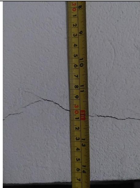
Fotografía 18. Se detallan fisuras de 0.3 mm.
