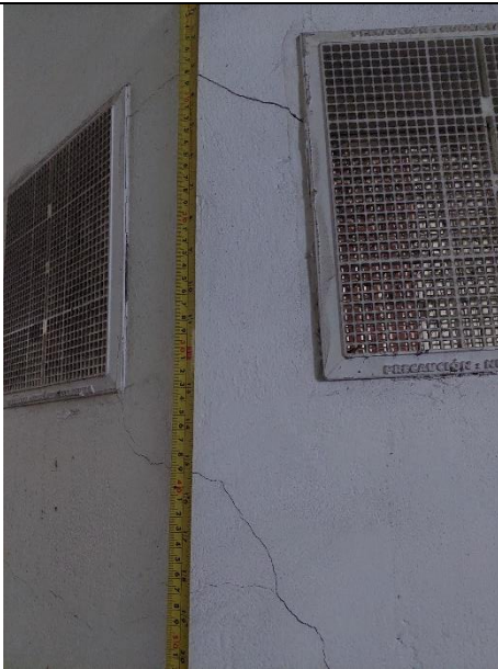
Fotografía 17. Medición fisuras y grietas muro divisorio primer piso.
