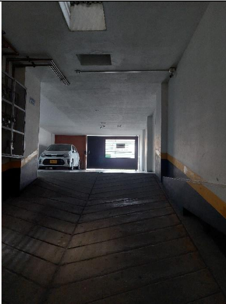
Fotografía 37. Rampa vehicular de acceso al sótano.
