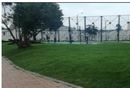
Figura 14. Acceso A Zona Deportiva 1 MG
