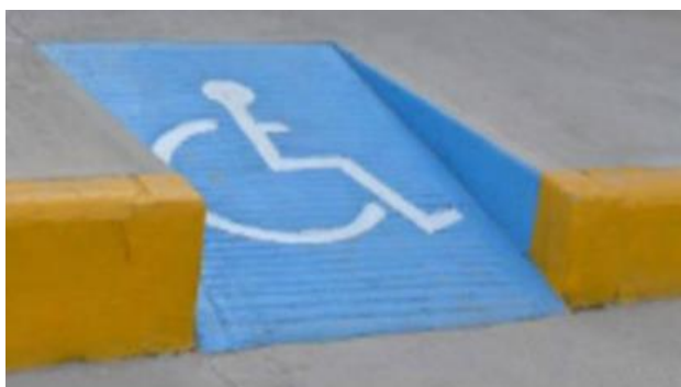
Figura 129. Demarcación De Señal
