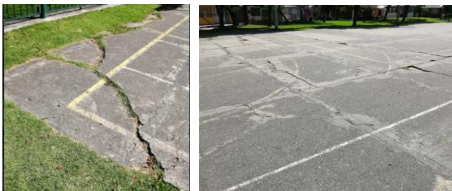
Figura 42. Pavimento De La Cancha Múltiple 2 SR
