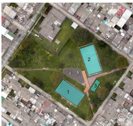
Figura 45. Zonas Deportivas – Vista Aérea SR
