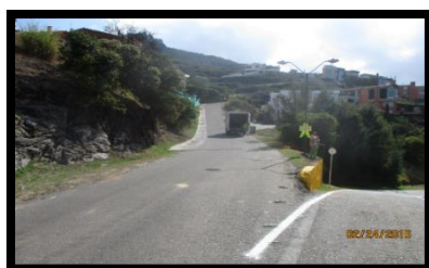
Fotografía 22. Implementacion pintura lineal, ANTES.
