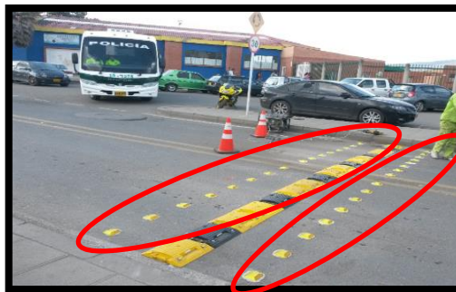
Fotografía 19. Tachas para visibilidad nocturna de resaltos.
