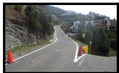
Fotografía 23. Implementacion pintura lineal, DESPUES.
