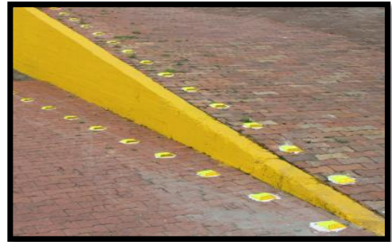
Fotografía 29. Muro de contención 1. DESPUES.
