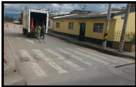
Fotografía 4. Calle 10 entre carrera 7 y 8, ANTES.
