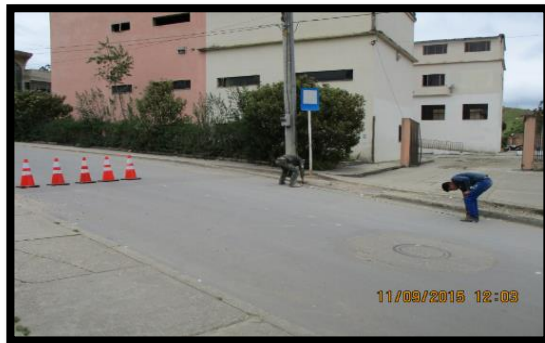
Fotografía 45. Vía puesto de salud. ANTES.
