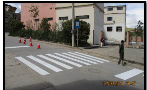
Fotografía 46. Vía puesto de salud. DESPUES.
