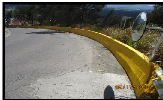
Fotografía 25. Muros de contención, DESPUES.
