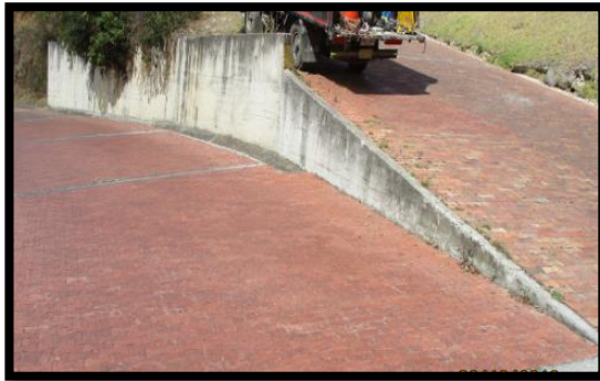
Fotografía 28. Muro de contención 1. ANTES.
