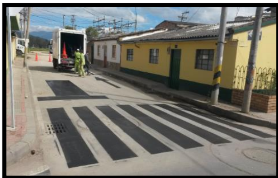
Fotografía 6. Calle 10 entre carrera 7 y 8, ANTES.
