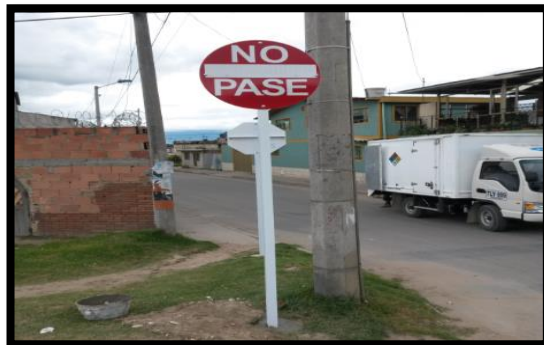
Fotografía 15. Instalación SR-04 Calle 17, DESPUES.
