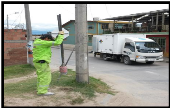
Fotografía 14. Instalación SR-04 Calle 17, ANTES.
