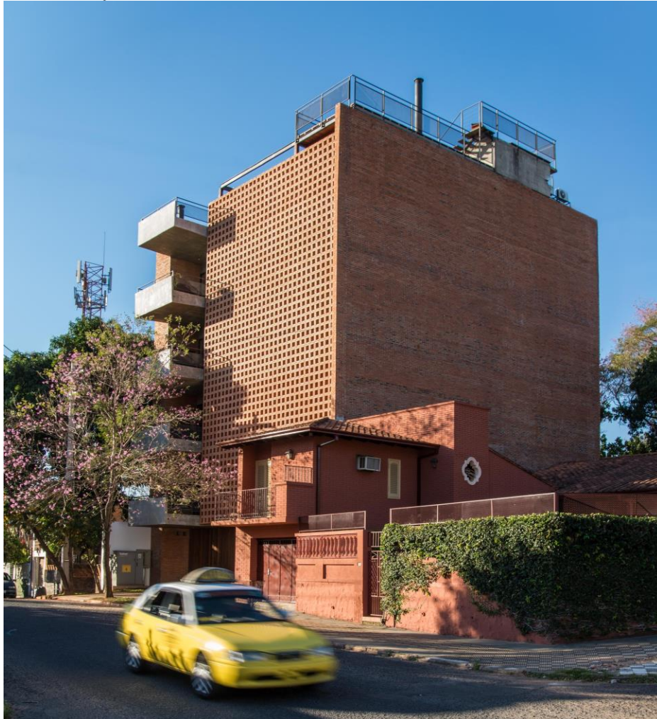
Figura 6. Fachada (edificio San Francisco)
