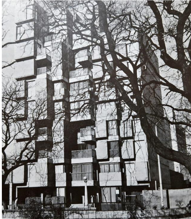
Figura 23. Fachada edificio Figueroa Alcorta 50
