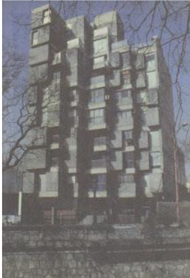
Figura 22. Fachada edificio Figueroa Alcorta 50
