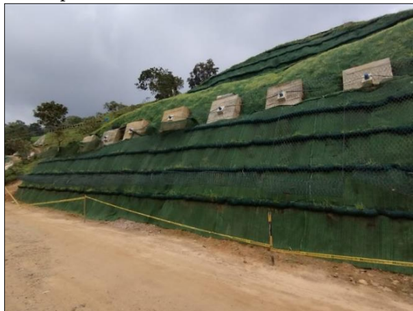
Figura 6. Obra de contención con un sistema combinado, anclajes postensados, manto sintético, malla eslabonada y siembra de pasto con semilla en la vía Chinácota – Ragonvalia
