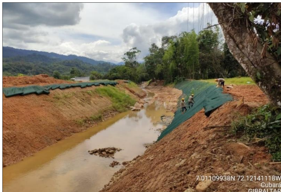
Figura 40. Instalación del manto
