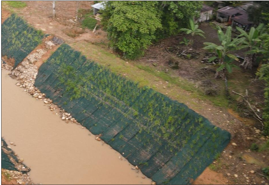
Figura 50 Crecimiento del vetiver por toma aérea
