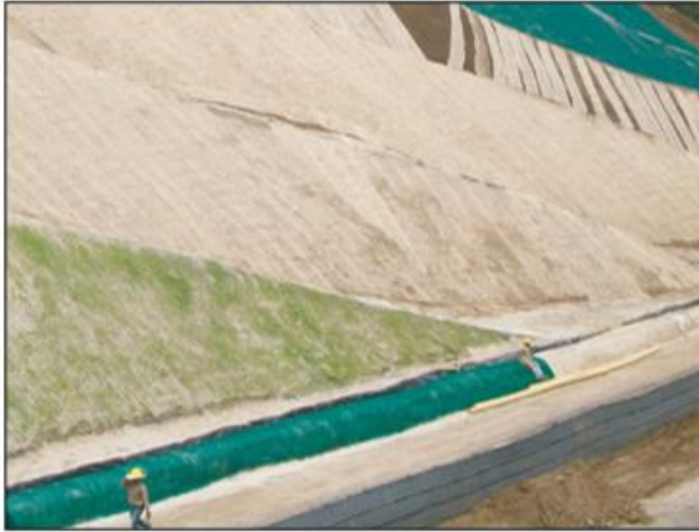
Figura 9. Agromantos instalación en taludes
