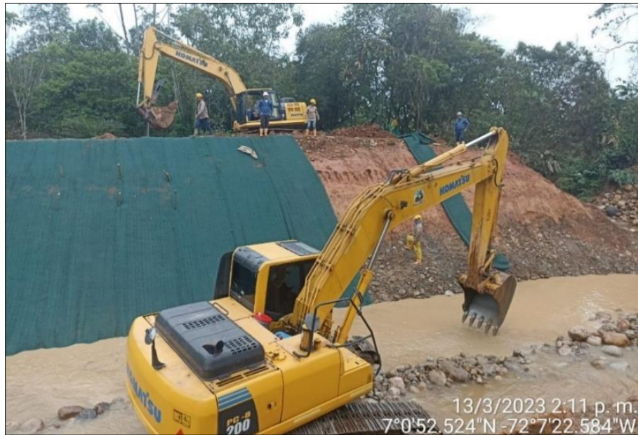
Figura 38. Instalación del manto
