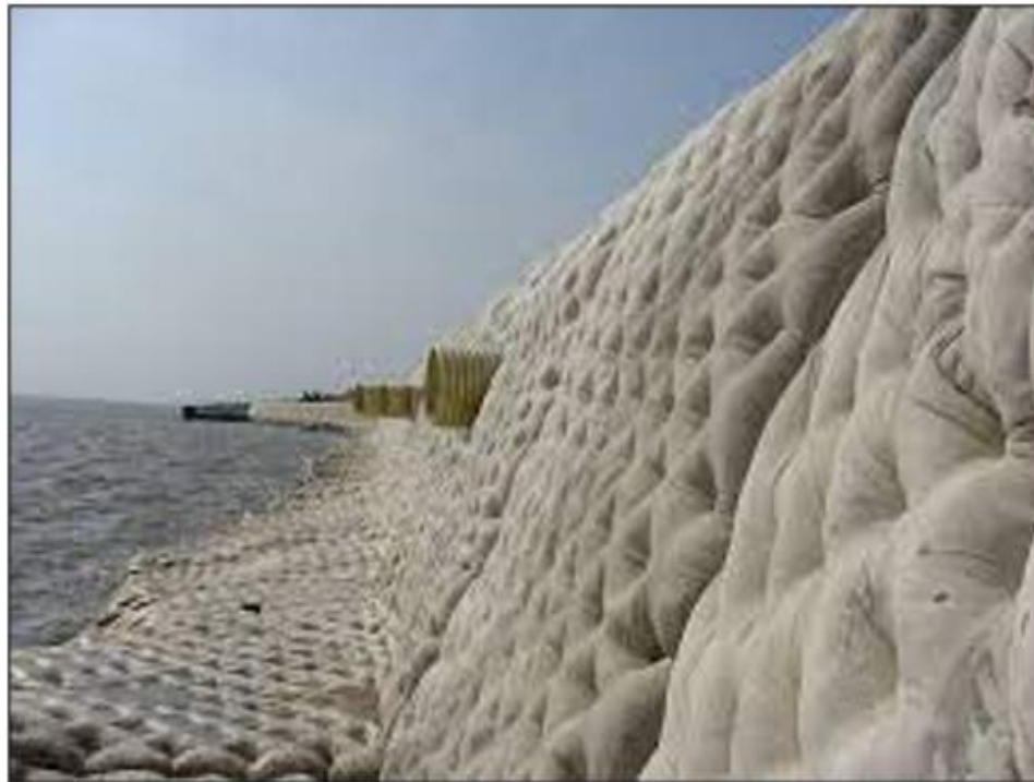
Figura 15. Flexocreto instalado en taludes con alta pendiente
