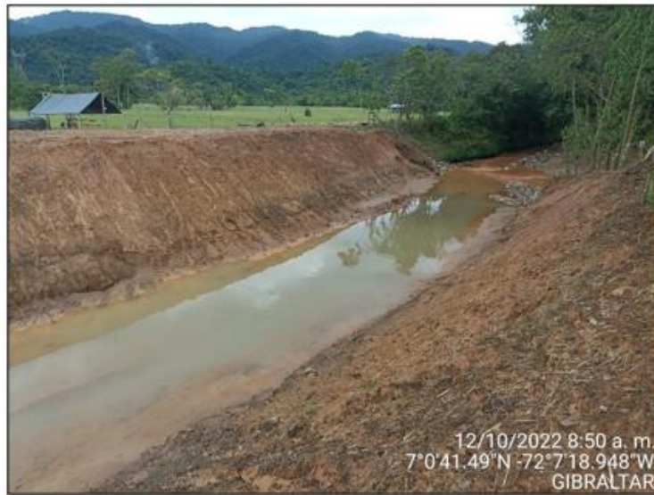
Figura 31. Tramo en intervención
