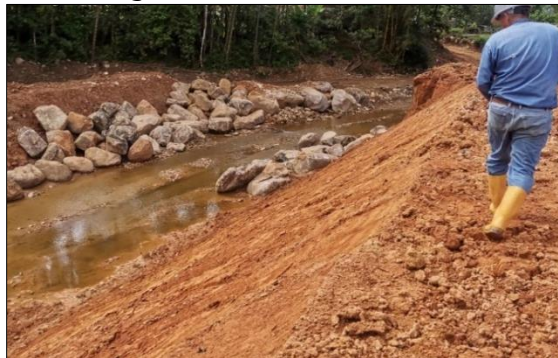
Figura 37. Riego de semillas en margen de la canalización
