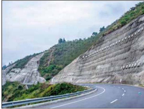
Figura 5. Obra de contención con anclajes postensados, concreto lanzado y malla electrosoldada en la vía Cúcuta – Pamplona
