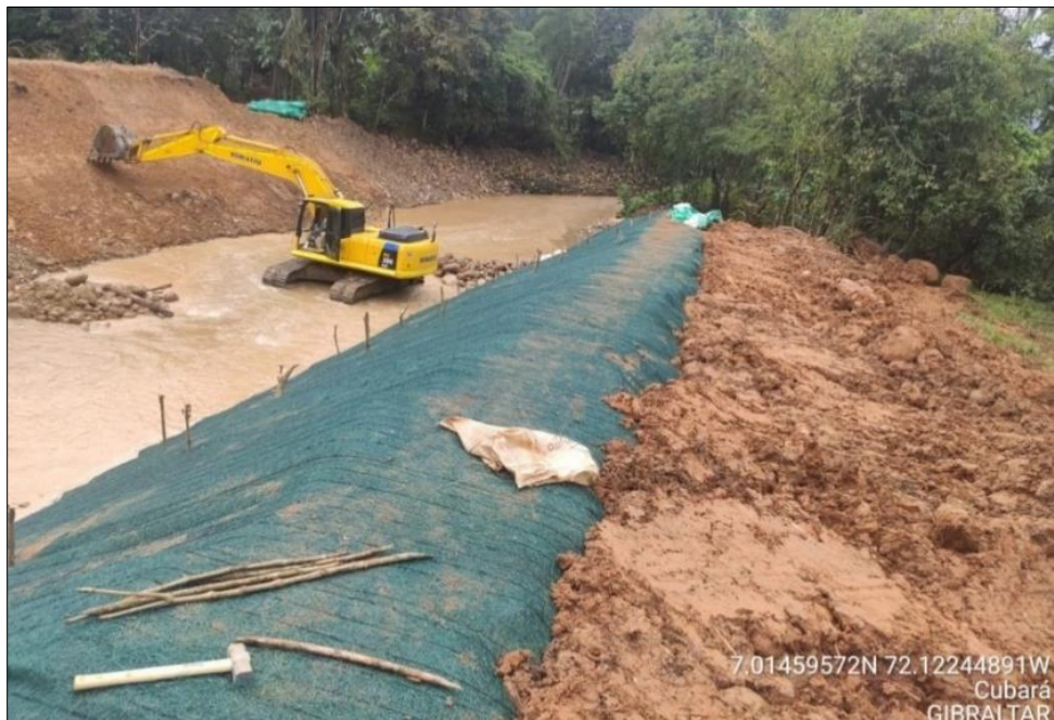
Figura 39. Instalación del manto
