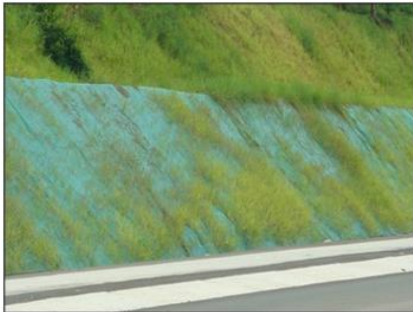
Figura 8. Uso del biomantos en taludes
