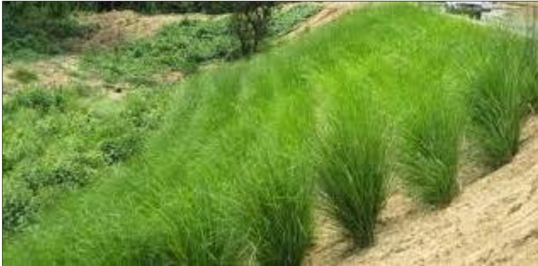
Figura 34. Uso del vetiver en taludes
