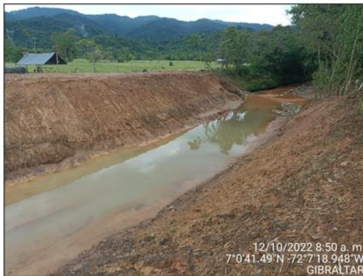
Figura 32. Tramo en intervención
