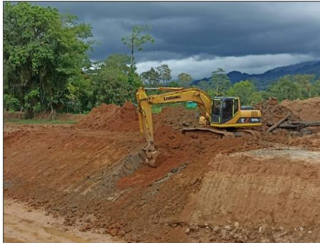
Figura 3. Conformación de taludes en la ejecución del proyecto
