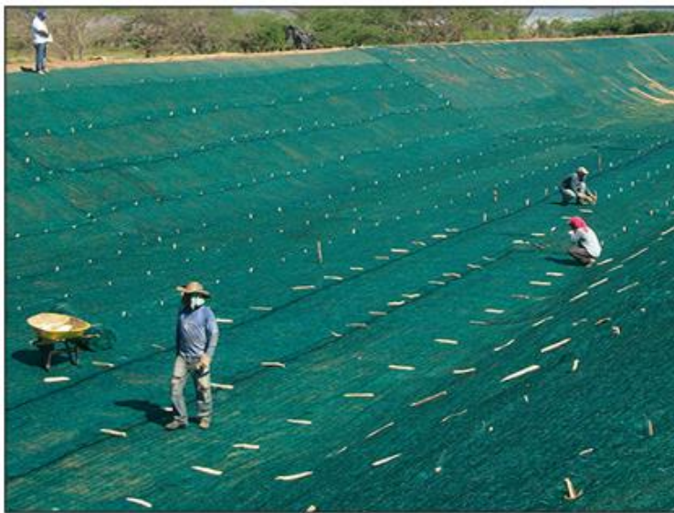
Figura 11. Uso del biomantos en taludes
