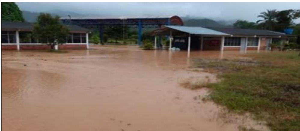
Figura 1. Estado de la Institución Educativa del corregimiento de Gibraltar en la temporada de lluvias del 2021
