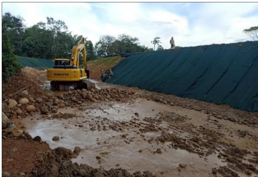
Figura 41 Instalación del manto
