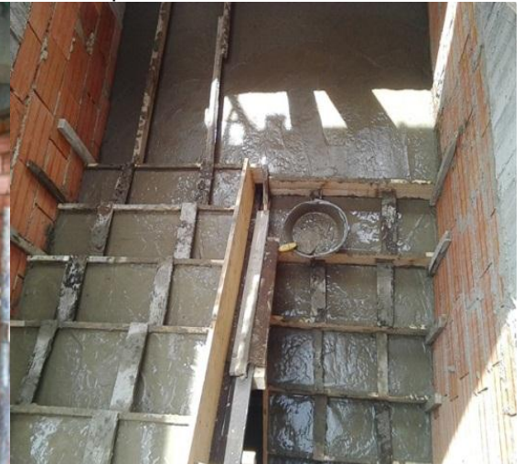
Fotografía 15. Fundición de concreto de 3000PSI para escalera
