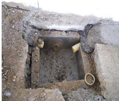
Fotografía 28. Tubería filtrante de 4" piedra rajón recubierto en geotextil desembocando en caja de inspección de 1.00m x 1.00m
