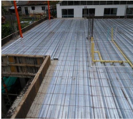
Fotografía 11. Lamina de Steel deck plenamente instalada, malla electrosoldada de 6mm.
