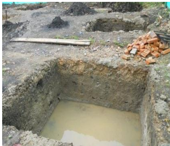
Fotografía 1. Mejoramiento al suelo con 40cm de concreto ciclópeo.
