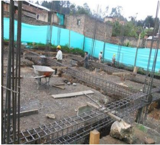
Fotografía 5. Amarre de aceros y estribos para vigas de cimentación.
