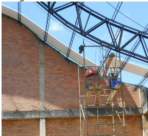
Fotografía 22. Inicio instalación de cubierta.
