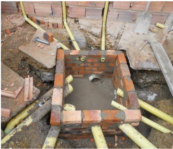
Fotografía 30. Construcción caja de inspección 1.00m x1.00m sanitaria, distribución tubería sanitaria
