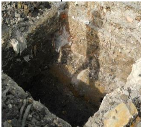
Fotografía 3. Tubería de concreto con varios años de antigüedad que pasará la excavación de zapatas.
