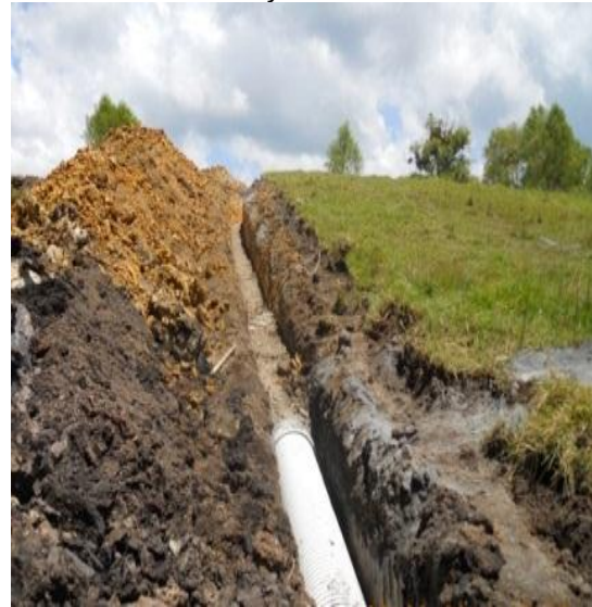
Fotografía 21. Instalación de tubería pozo PZ 9 y PZ 10
