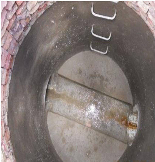
Fotografía 20. Detalle interior PZ 9
