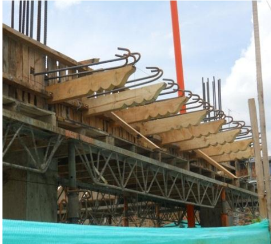
Fotografía 7. Canes y refuerzo de acero para el voladizo de balcones
