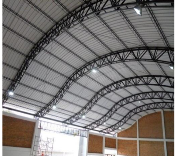
Fotografía 35 Luminarias leed de 12watts
