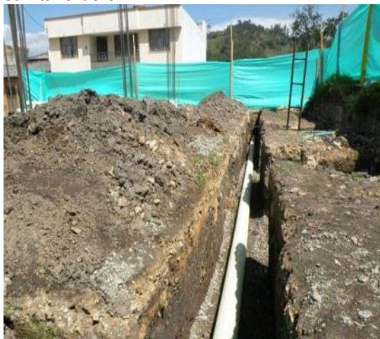
Fotografía 38. Instalación de nueva tubería sanitaria de 8”.
