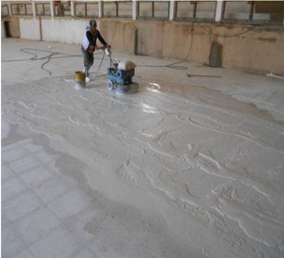
Fotografía 34. Pulida y nivelación de baldosín.
