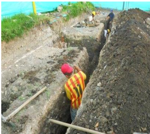
Fotografía 36. Excavación manual para alcantarillado sanitario de viviendas aledañas.
