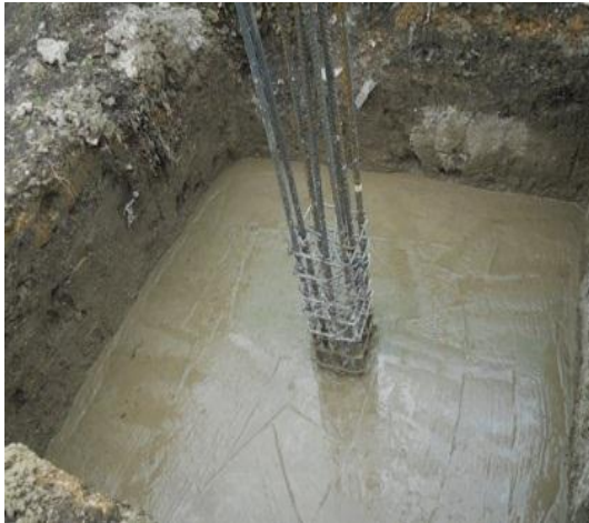
Fotografía 4. Zapata fundida en concreto de 3000 PSI
