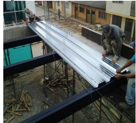
Fotografía 10. Instalación lamina de Stell Deck
