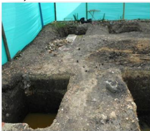
Fotografía 2. Excavación de zapatas de 2.20m y 1.80m
