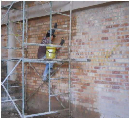
Fotografía 29. Limpieza de mampostería con ácido nítrico.
