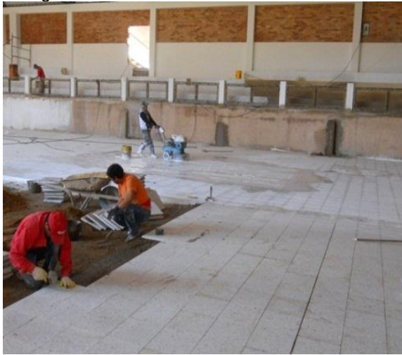
Fotografía 33. Instalación de baldosín
