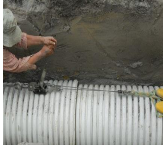
Fotografía 18. Instalación de tubería con ayuda de garrucha empatándola los 30cm estipulados por el fabricante
