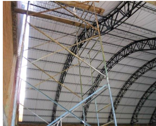
Fotografía 23. Instalación gran parte de la cubierta.
