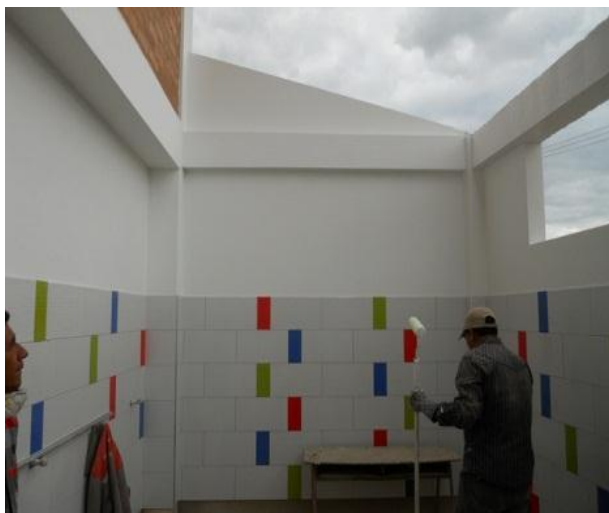
Fotografía 32. Estuco y pintura baños de hombres.
