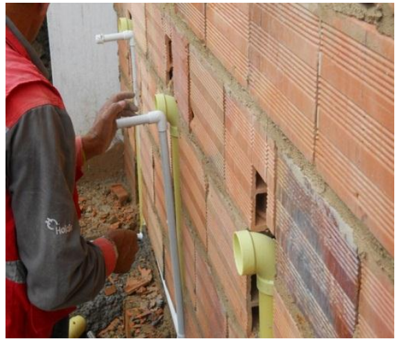
Fotografía 31 Instalación de tubería de agua potable
