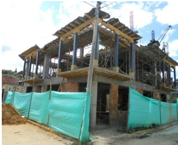
Fotografía 16. Estructura en madera para balcones
