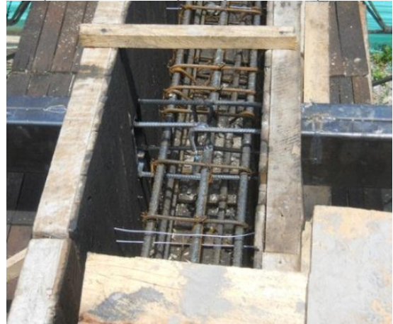
Fotografía 8. Detalle unión y soldadura de perfiles entre si y a viga de entrepiso.
