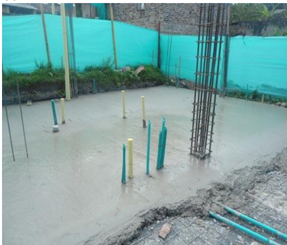
Fotografía 6. Fundición placa de cimentación de 10cm
