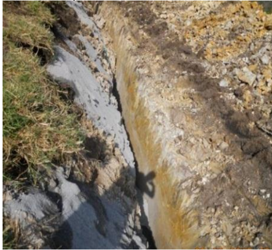
Fotografía 17. Excavación de 1m de ancho por 1m de altura para instalación de tubería
