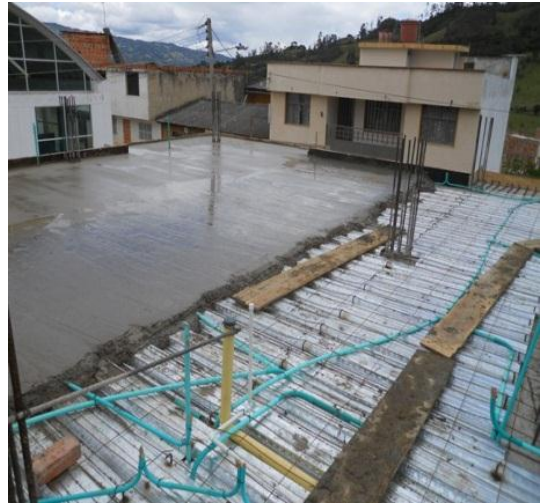
Fotografía 12. Parte de placa de concreto fundida
