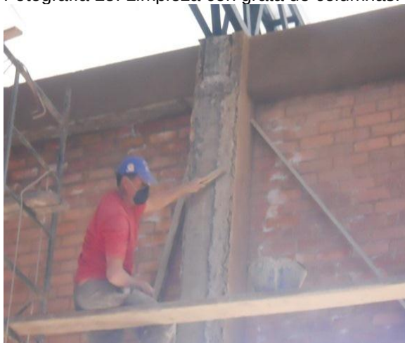
Fotografía 25. Limpieza con grata de columnas.
