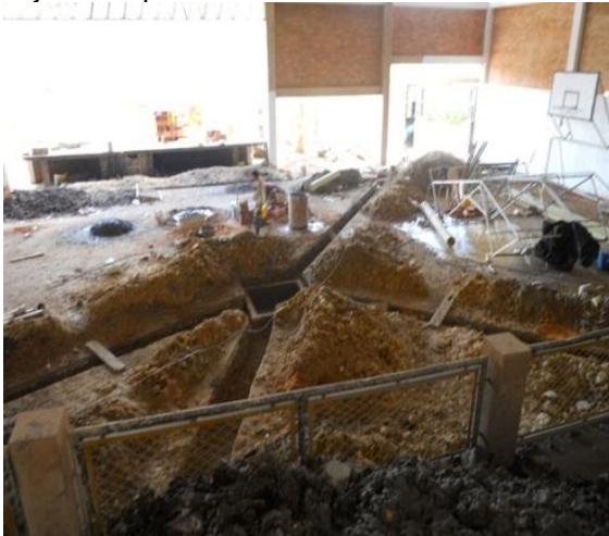
Fotografía 27 Excavaciones que conducen a la caja de inspección de 1.20m x 1.20m
