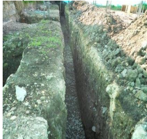
Fotografía 37. Encamado de recebo con un espesor de 5cm.
