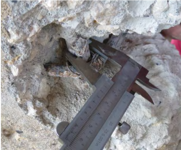
Refuerzo longitudinal (Columnas)
