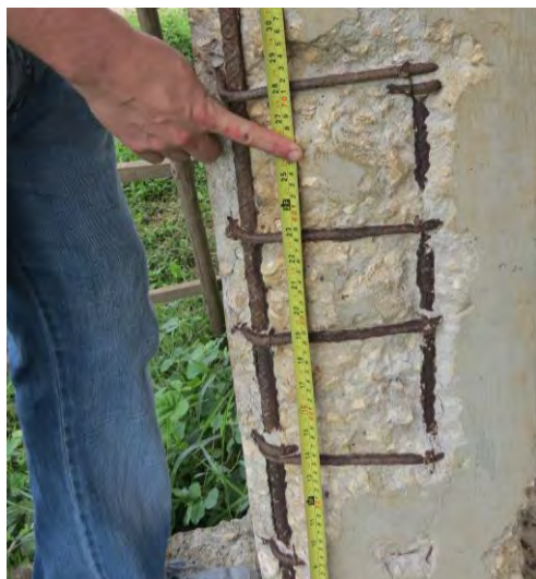
Foto 3 y 4: Verificación de dimensiones y espaciamientos.
