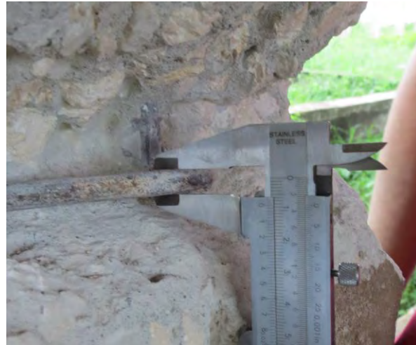
Refuerzo Transversal (Columnas)
