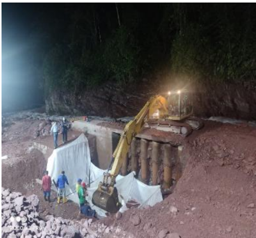
Fotografía 23: Actividad de instalación de geotextil
