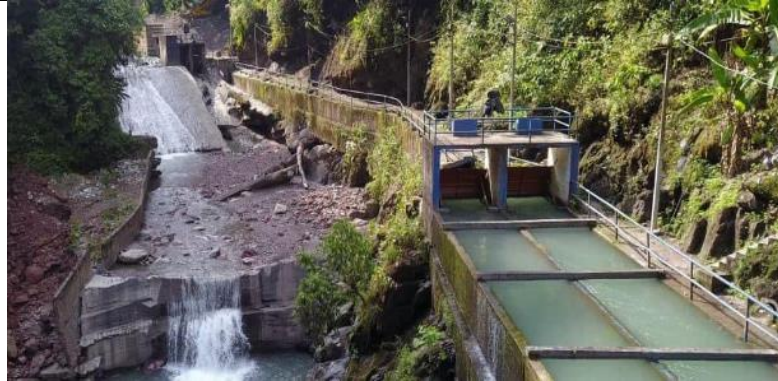
Fotografía del antes de la Bocatoma Quebrada la Honda donde se puede apreciar la magnitud del evento.
