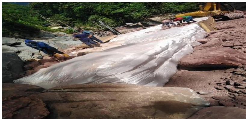
Fotografía 25: Actividad de instalación de las geobolsas
