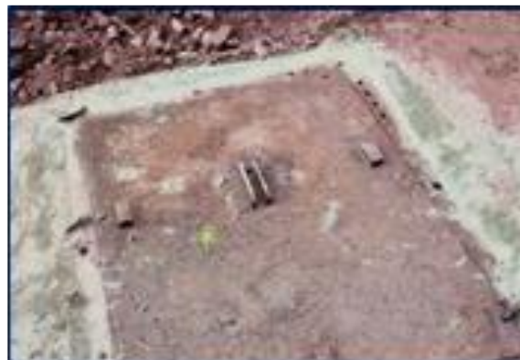
Fotografías: Ubicación de huecos por destrucción de tapas en concreto de cámara de derivación, canal de aducción que ocasionaron el taponamiento en las estructuras de captación y Elaboración de tapas en acero ASTM A36 para evitar posteriores taponamientos.
