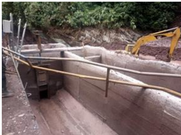
Fotografía: Maquinaria pesada retirando material de la cámara de captación.
