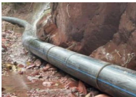
Fotografías: Instalación de anclajes en varilla de 1” y guaya en acero de ½” en tubería de aducción PEAD 630 mm, con el fin de proteger tubería en línea de aducción.
