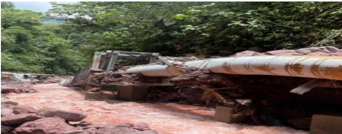
Fotografía 7: Actividad de desmantelamiento de viaducto"
