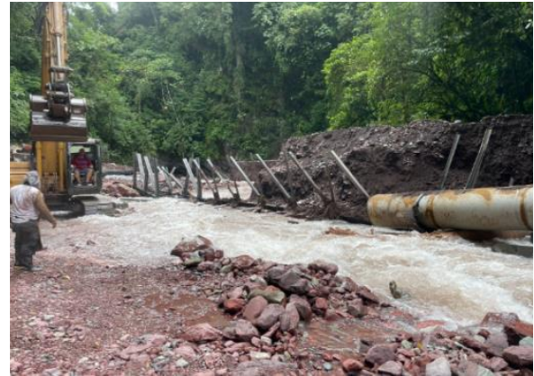
Fotografía 9: Estado del viaducto
