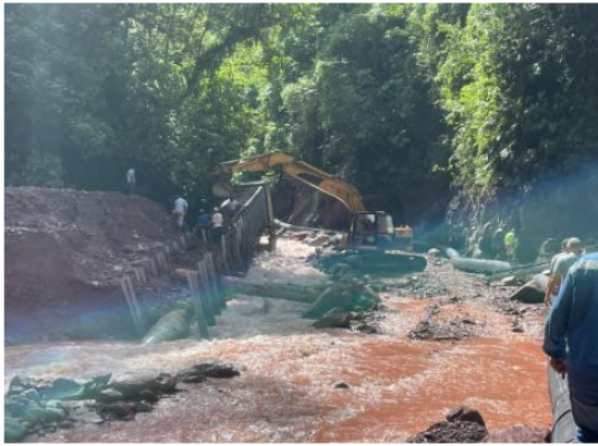
Fotografía 8: Actividad de desmantelamiento de viaducto
