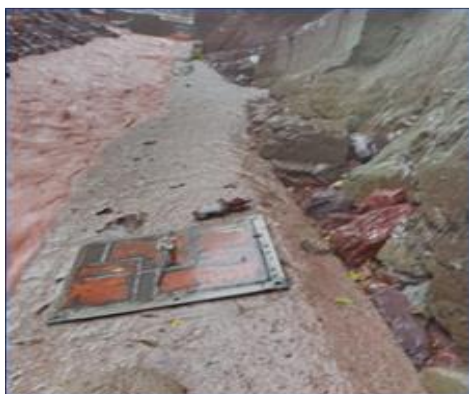
Fotografías: Ubicación de huecos por destrucción de tapas en concreto de cámara de derivación, canal de aducción que ocasionaron el taponamiento en las estructuras de captación y Elaboración de tapas en acero ASTM A36 para evitar posteriores taponamientos.
