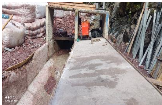
Fotografías: Sellado con tapa superior en concreto reforzado en tanque desarenador para evitar colmatación con material por crecientes de la Quebrada la Honda.
