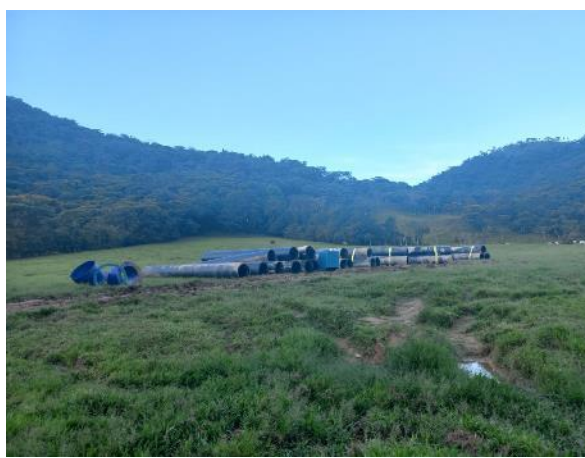
Fotografía 4: Estado de recopilación de la tubería PEAD en el sitio.
