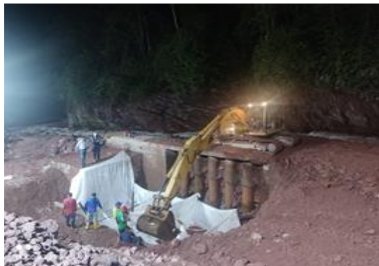
Fotografías: Instalación de Geobolsas en la captación para proteger canal de aducción y desarenador.
