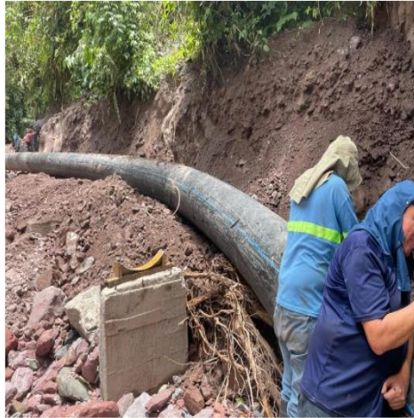
Fotografía 6: Actividad de instalación de tubería PEAD 24"
