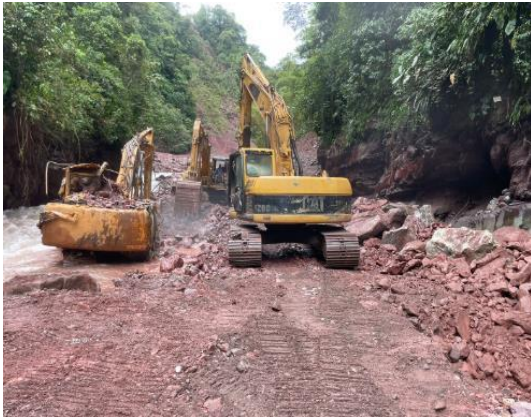
Fotografía 17: Actividad de remoción de maquinaria
