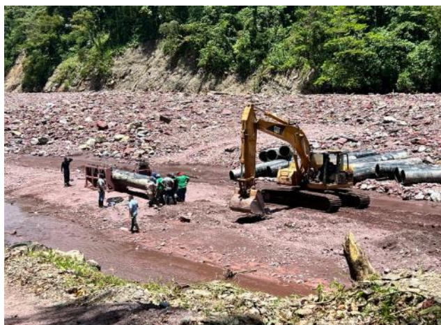
Fotografía 5: Actividad de ingreso de retro excavadora y equipo de termo fusión.
