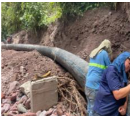
Fotografías: Cambio e Instalación de tubería en aducción PEAD 630 mm, debajo del tanque desarenador hasta sector Ricardo Hernández por daño en estructura de viaductos A.P de 33”.
