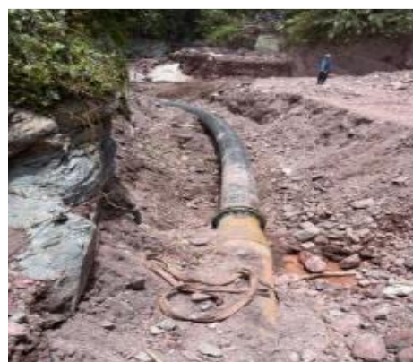
Fotografías: Cambio e Instalación de tubería en aducción PEAD 630 mm, debajo del tanque desarenador hasta sector Ricardo Hernández por daño en estructura de viaductos A.P de 33”.
