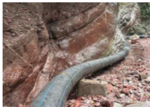
Fotografías: Cambio e Instalación de tubería en aducción PEAD 630 mm, debajo del tanque desarenador hasta sector Ricardo Hernández por daño en estructura de viaductos A.P de 33”.
