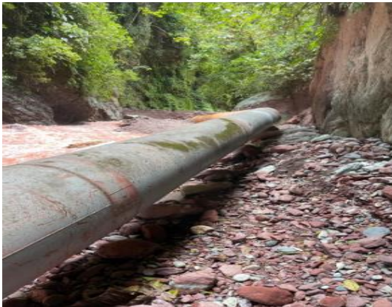
Fotografía 10: Se realiza inspección sobre la tubería CCP
