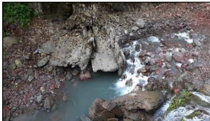
Flujo del agua desviado hacia la roca.
