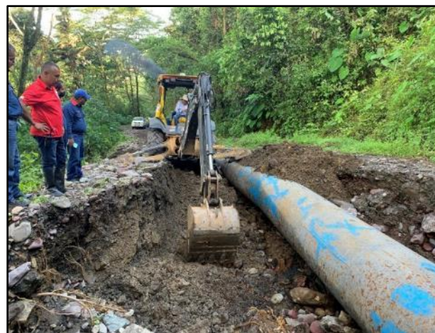
Maniobras con la retroexcavadora para la alineación de la tubería.
