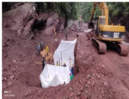
Fotografías: Instalación de Geobolsas en la captación para proteger canal de aducción y desarenador.
