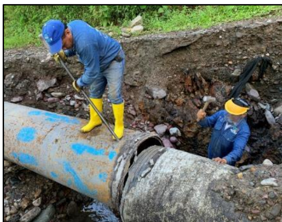
Maniobras con la retroexcavadora para la alineación de la tubería.
