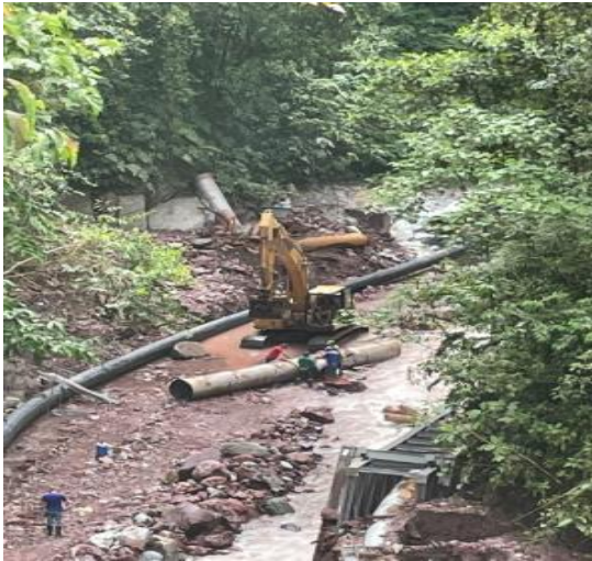
Fotografía 21: Actividad de recuperación de tubería
