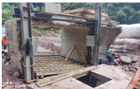
Fotografías: Sellado con tapa superior en concreto reforzado en tanque desarenador para evitar colmatación con material por crecientes de la Quebrada la Honda.
