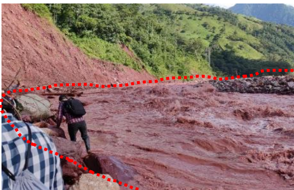
Fotografía 1: Camino mular en sector Castrillo, se evidencia derrubios y erosión que dificultan la movilización. Fuente: EAAV ESP, 2022
