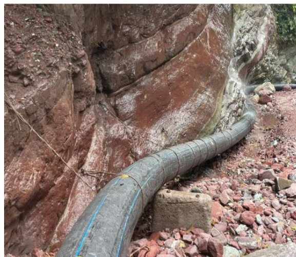
Fotografía 15: Actividad de medición de tramo faltante de tubería
