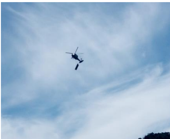
Fotografía 3: Actividad de traslado aéreo de la tubería PEAD.
