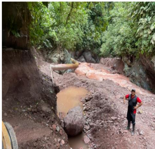
Fotografía 13: Actividad de medición de tramo faltante de tubería
