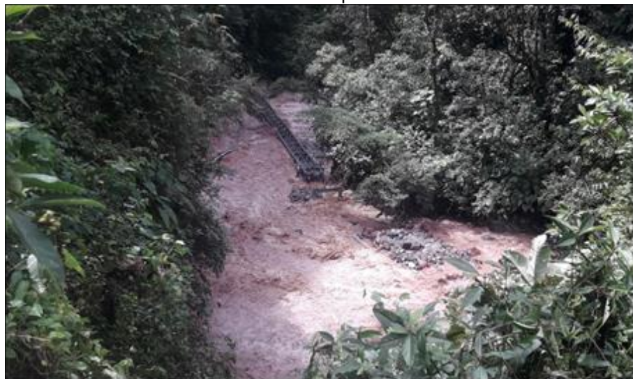
Línea de Aducción sobre viaductos abajo de Bocatoma
