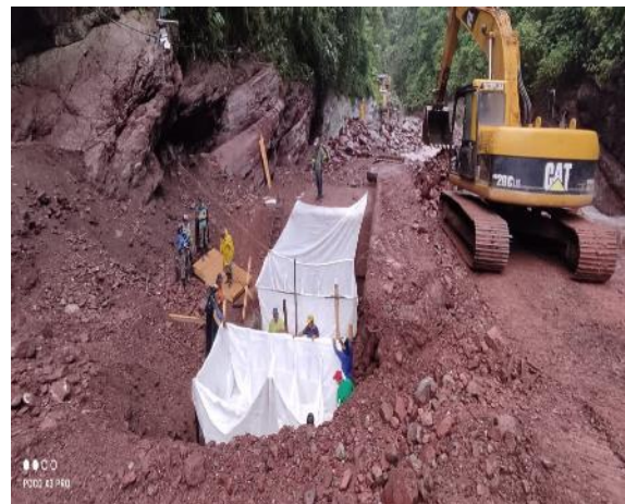
Fotografía 24: Actividad de relleno del geotextil
