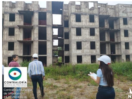
Figura 7. Visita técnica a Urbanización La Victoria.
