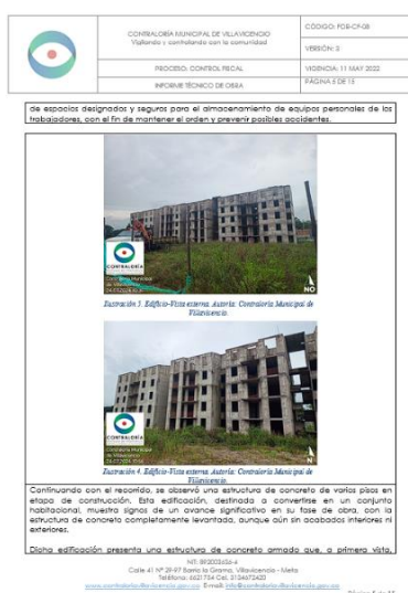
Figura 19. Informe técnico de obra Urbanización La Victoria.
