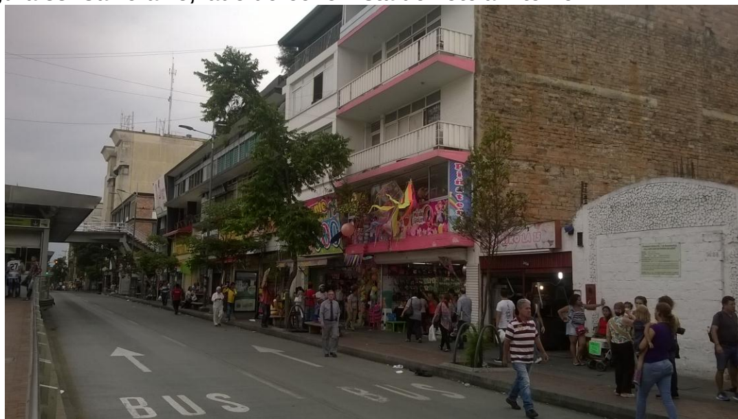
Figura 38. Carrera 15, lado derecho vista del lote a intervenir
