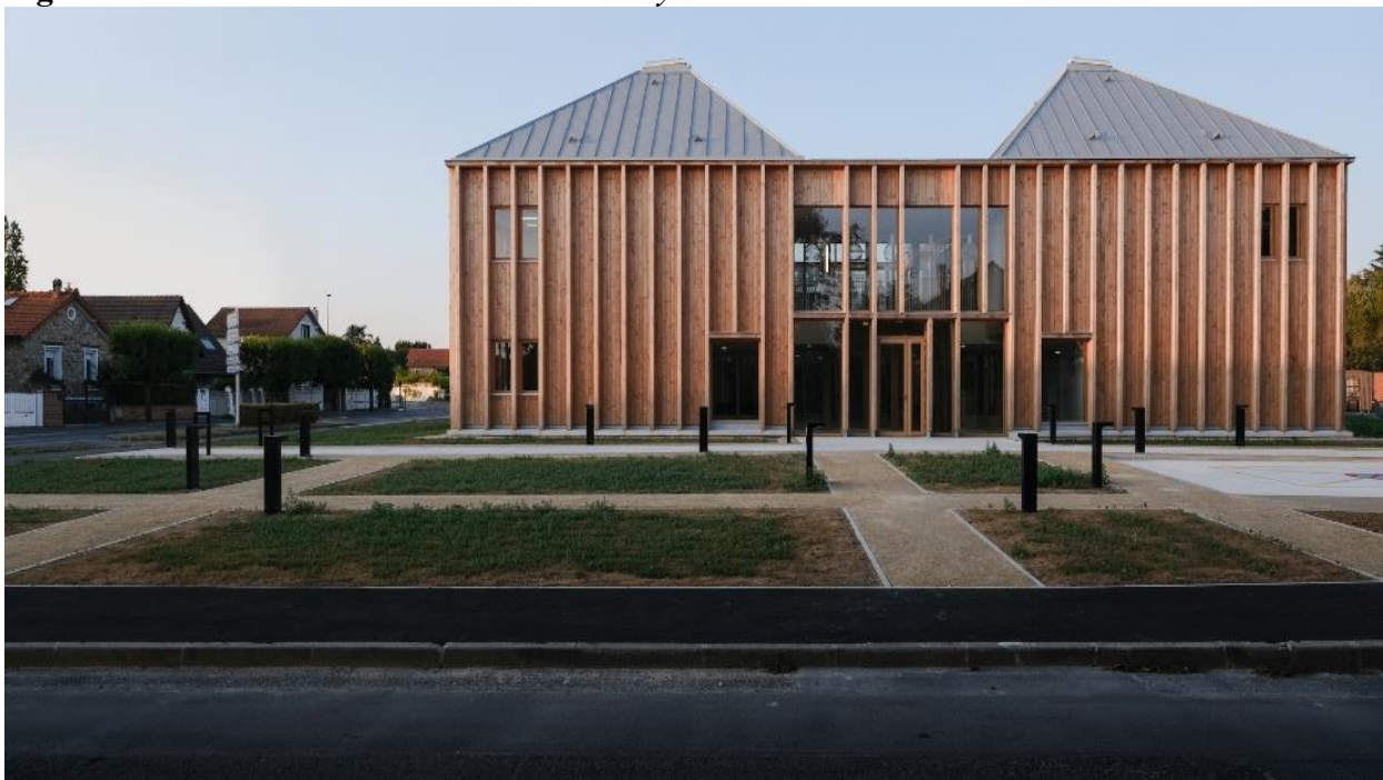
Figura 25. Fachada de centro medico Taverny / MAAJ Architectes
