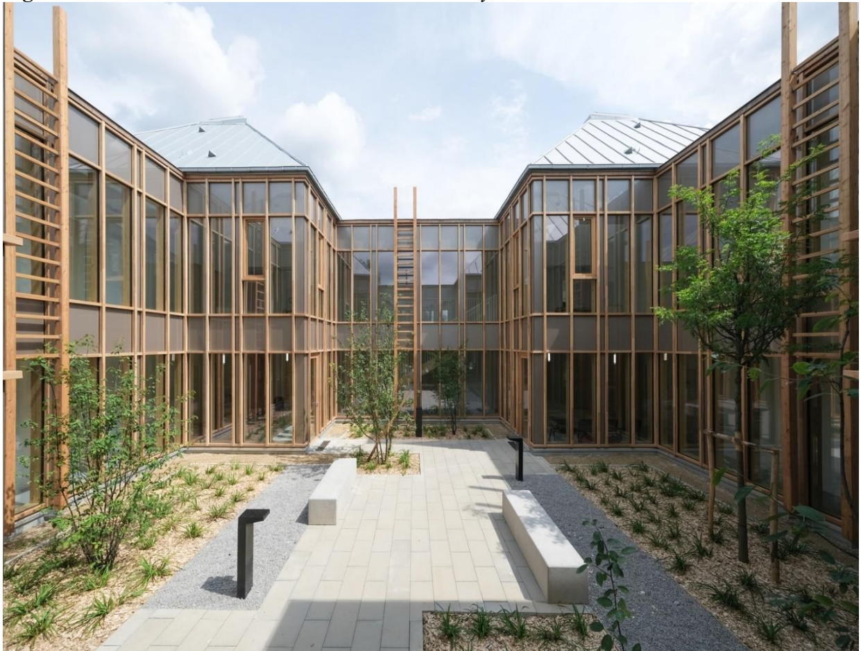
Figura 30. Foto Interior 02 del centro médico Taverny / MAAJ ARCHITECTES
