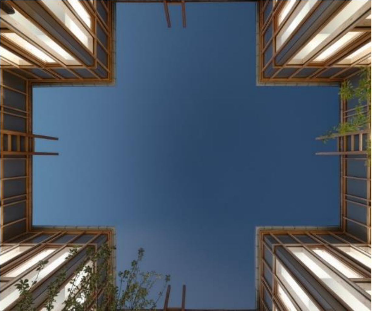
Figura 28. Foto 02 de centro medico Taverny / MAAJ ARCHITECTES
