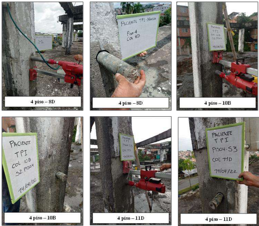
Figura 22. Extracción núcleos de concreto
