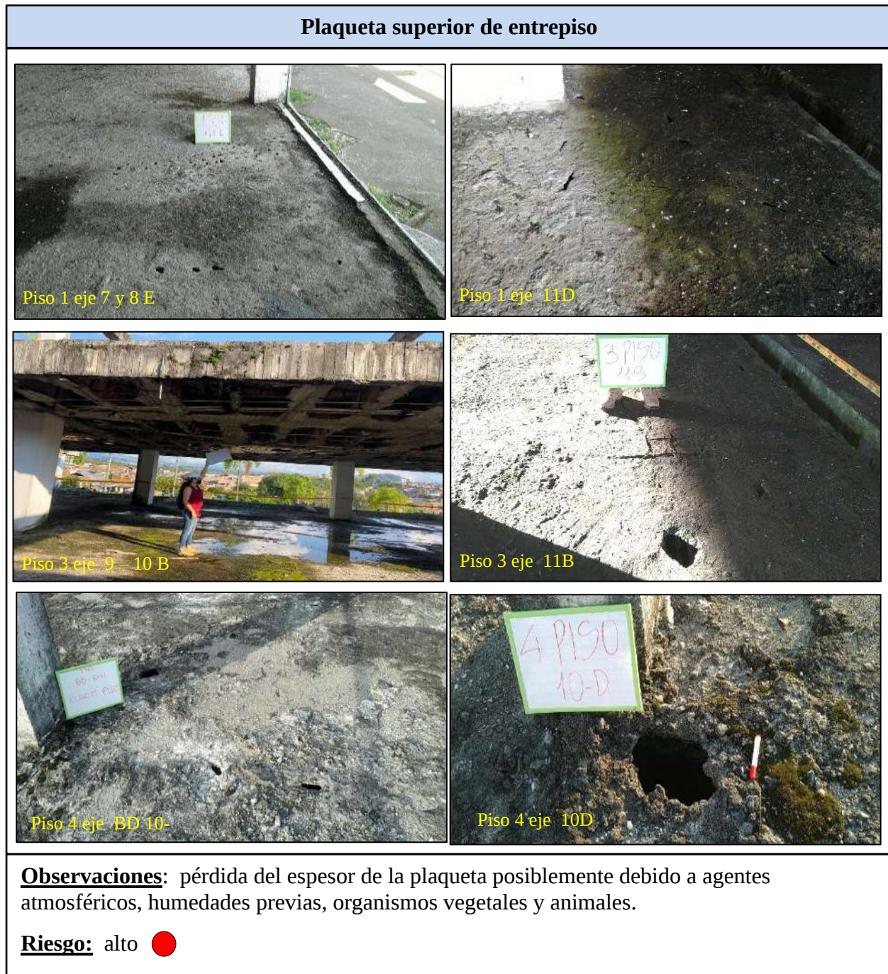
Figura 26. Análisis de riesgos estructurales - plaqueta superior entrepiso
