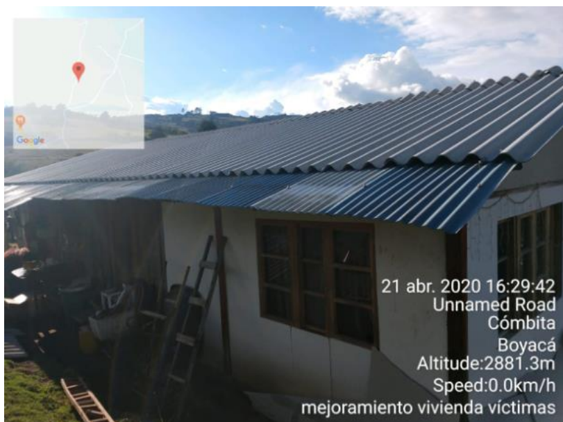
Ilustración 14. Mejoramiento de Vivienda (Cubierta)
