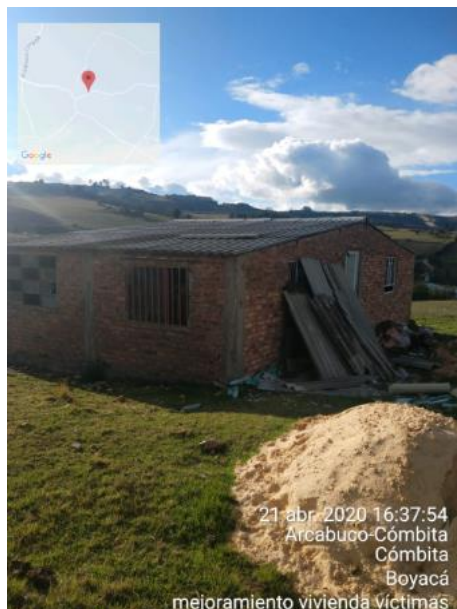
Ilustración 15. Mejoramiento de Vivienda (Construcción de casa)
