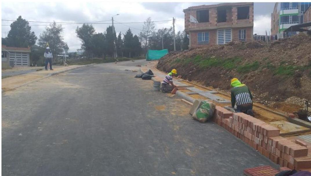
Ilustración 22. Calle 3, Parte Asfáltica
