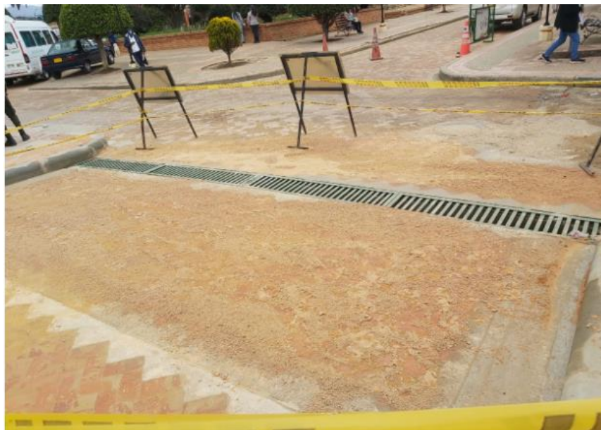
Ilustración 26. Alcantarilla cierre obra, calle 3
