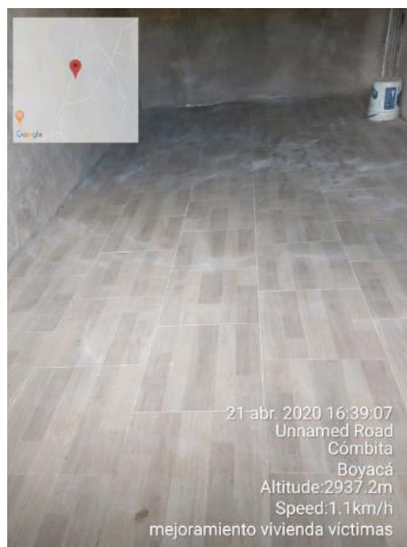
Ilustración 13. Mejoramiento de Vivienda (Piso)
