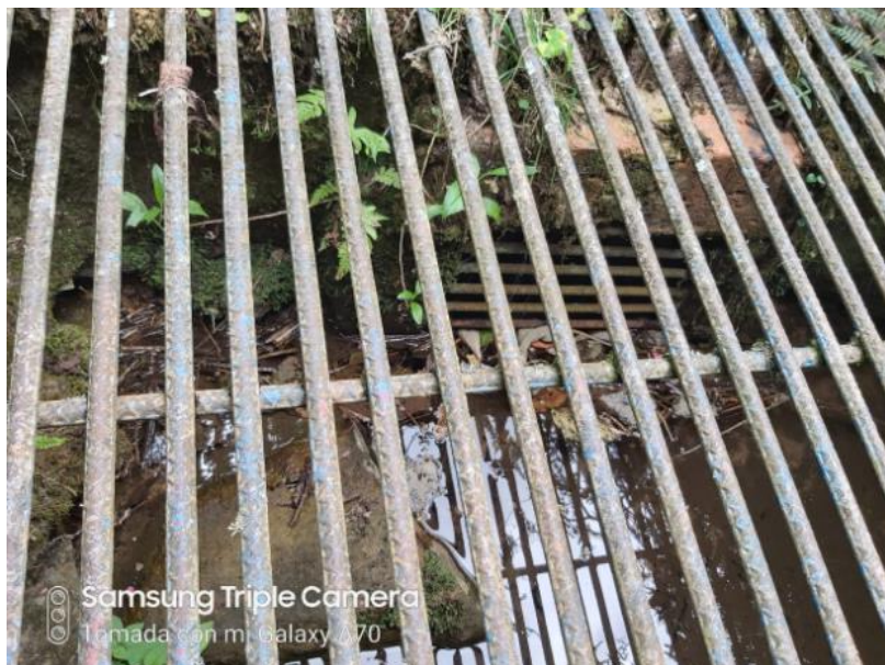
Ilustración 5. Método de Captación, bocatoma lateral.
