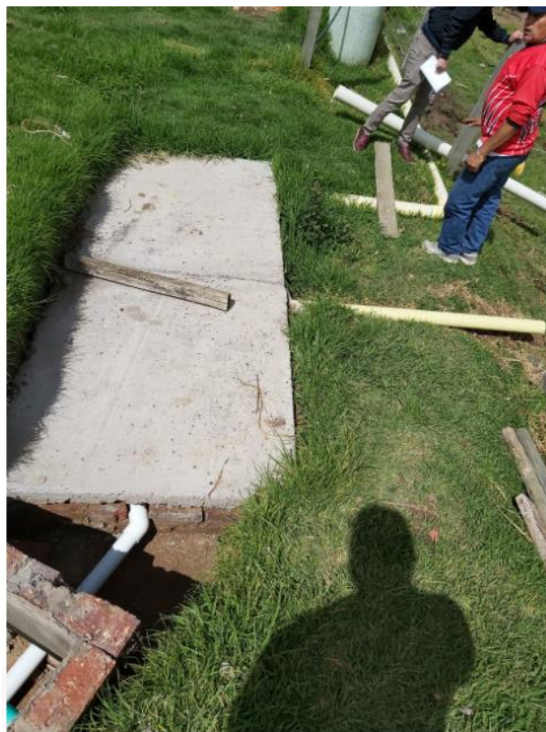
Ilustración 9. Pozo Séptico, Vereda la Concepción
