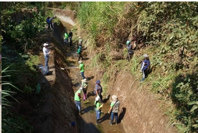
Figura 27. Jornada de Limpieza de Cauce. Quebrada El Toro, Sardinata y Río Lengupá – San Luis de Gaceno
