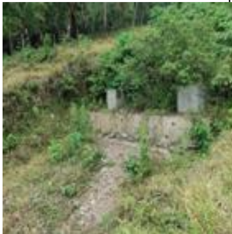
Figura 33. Estado Actual de la Obra Convenio 027-15. Municipio de Santa María
