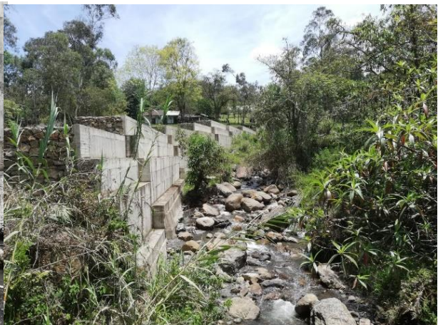
Figura 23. Visita Municipio La Capilla Convenio 024-18. Muro de Contención
