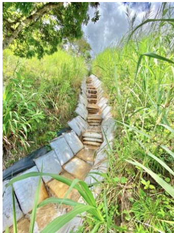
Figura 38. Estado de la obra Convenio 023-18. Municipio de Tenza
