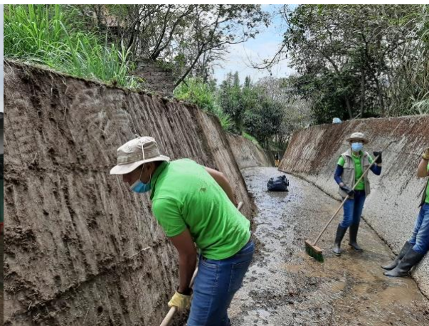
Figura 25. Jornada de Limpieza de Cauce. Quebrada Los Perros – Tibaná
