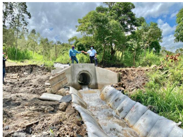
Figura 39. Estado de la obra Convenio 023-18. Municipio de Tenza
