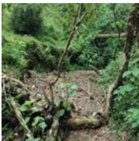
Figura 14. Visita Municipio Santa María Convenio 027-15. Rebose de material de arrastre sobre el canal.
