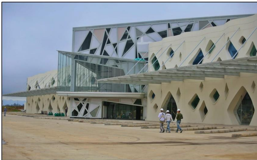
Figura 10. Fachada posterior terminal de Tunja.
