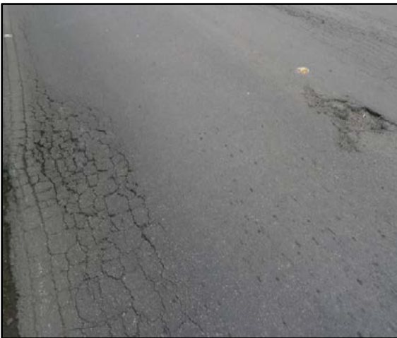
Piel de cocodrilo al borde de la vía de estudio junto a bache ocasionado por fin de vida útil
