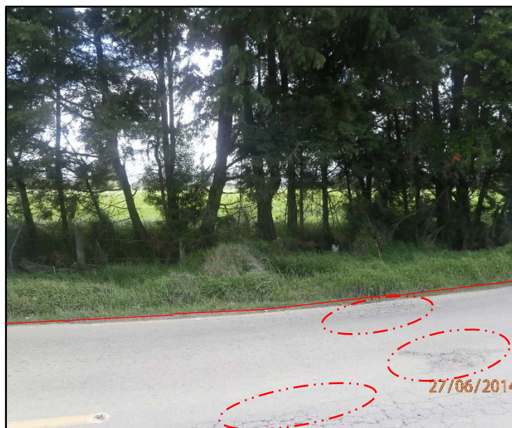
Figura 4- 2. Problemas de fisuramiento y asentamiento en las vía de estudio.
