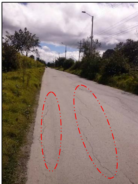
Figura 4- 2. Problemas de fisuramiento y asentamiento en las vía de estudio.
