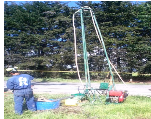
Instalación de torre para extracción de muestras
