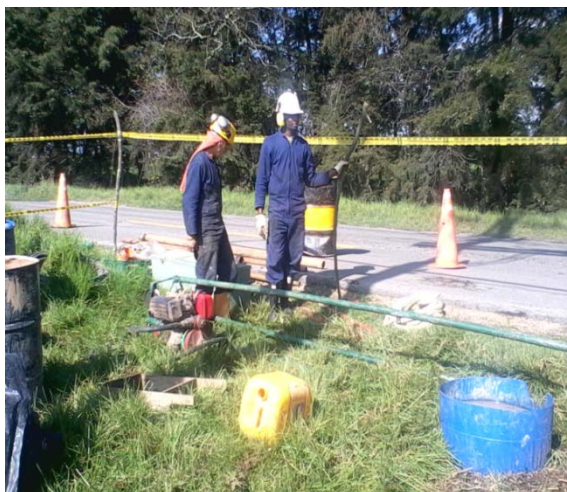
Grupo de trabajo instalando torre.
