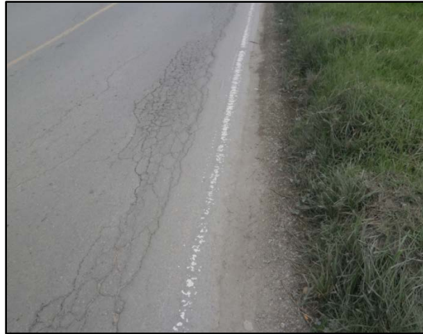
Fin de vida útil de asfalto presentada en la vía de estudio
