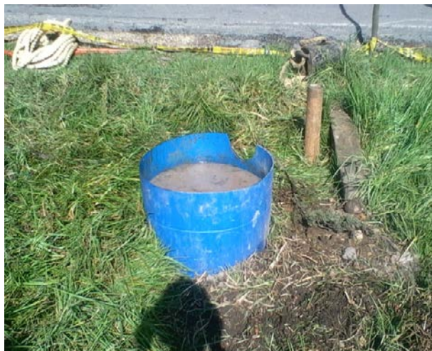
Instalación de tanque o pozo de retorno para lavado de perforación mecánica
