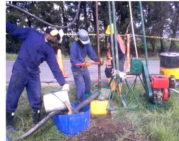
Extracción de muestras, llevado a cabo por el perforador y sus dos auxiliares.
