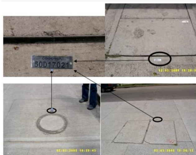
Figura 57. Ilustración placa de información del propietario de la infraestructura
