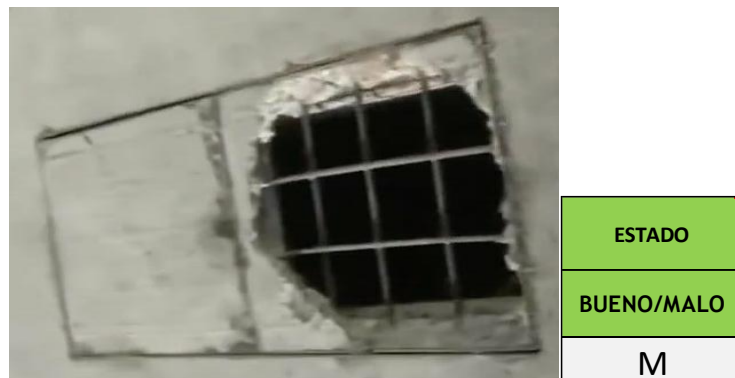
Figura 58. Ilustración estado de la cámara subterránea
