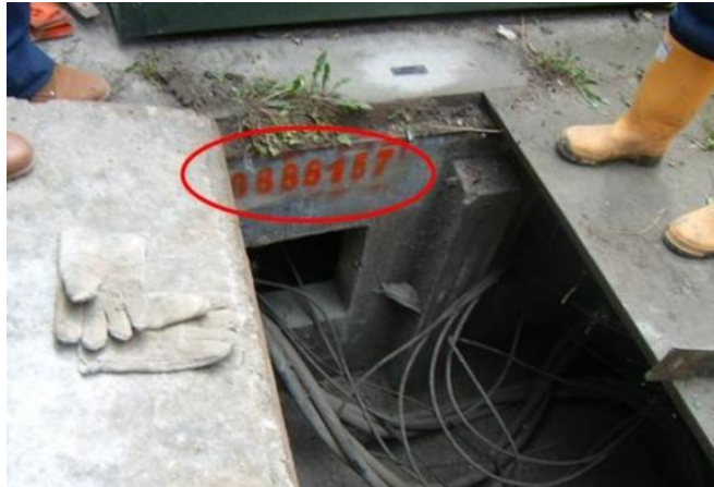
Figura 56. Ilustración número de identificación de la infraestructura (cámara)
