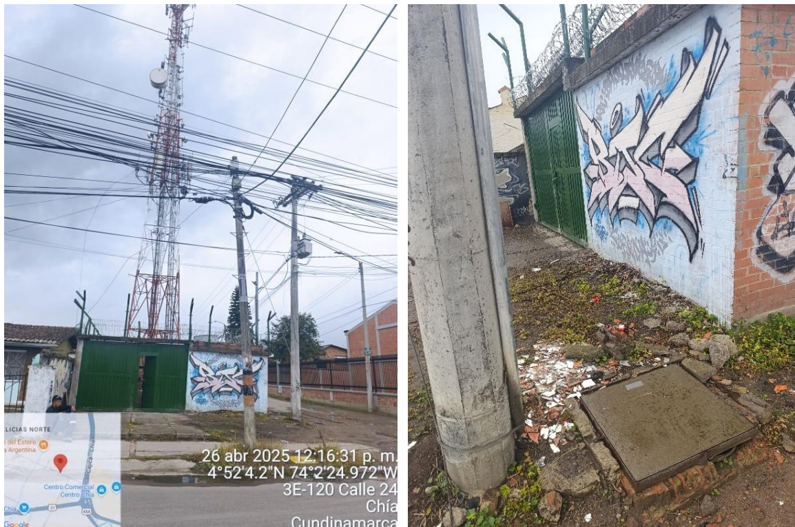
Figura 85. Ilustración ubicación (terreno) punto físico de la OLT
