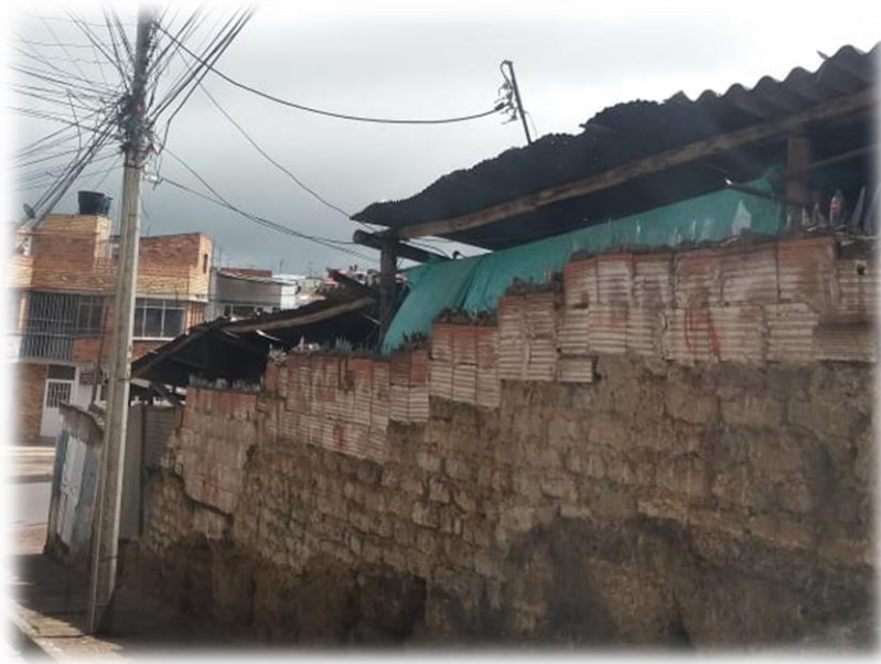
Imagen 40 Detalle elementos no estructurales de cerramiento.
