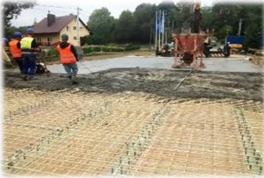
Imagen 12 Implementación de obras
