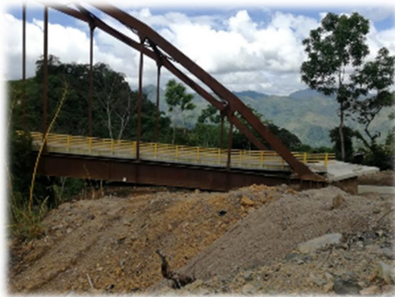
Imagen 23 Vista del puente que se mantuvo.
