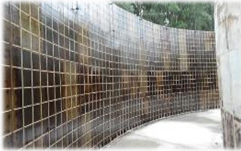
Imagen 14 Implementación de obras
