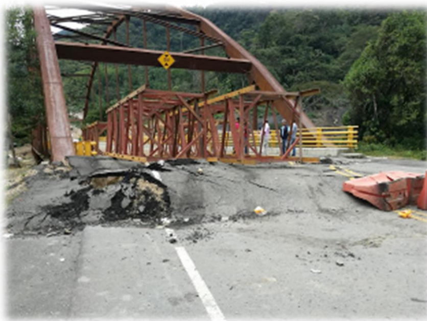
Imagen 26 Estribo margen izquierdo aguas abajo.
