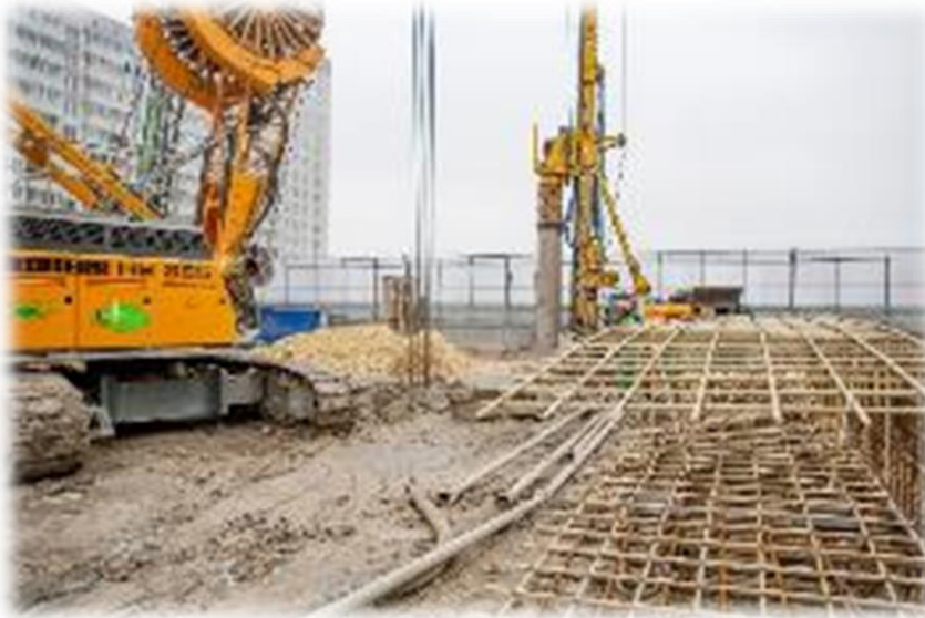
Imagen 13 Implementación de obras
