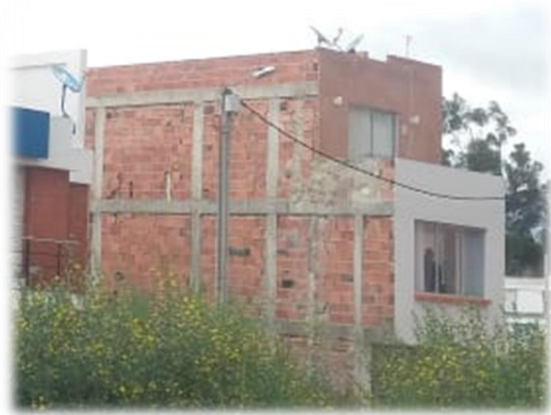
Imagen 41 Detalle elementos no estructurales de muros medianeros y de cubierta.
