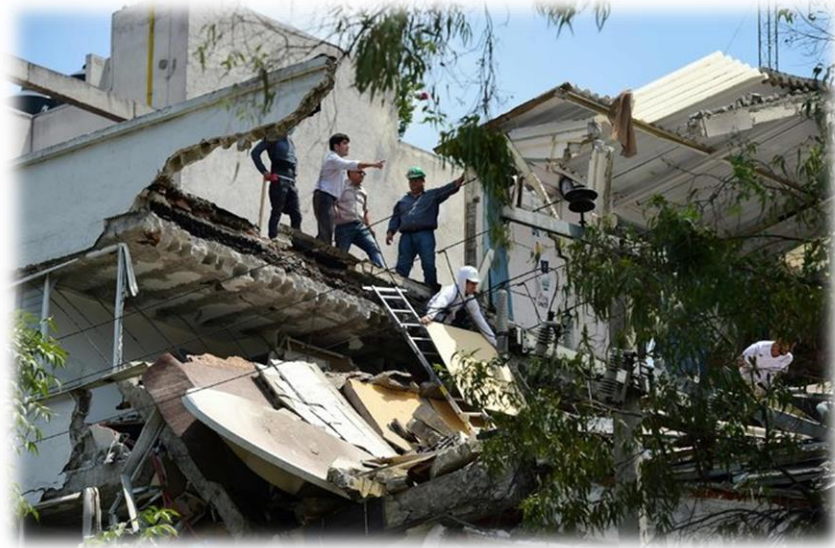
Imagen 34 Colapso de edificio después del terremoto en Ciudad de México.
