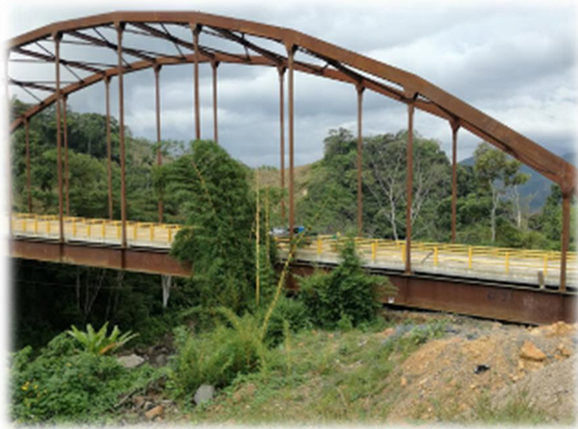
Imagen 25 Vista total del puente.
