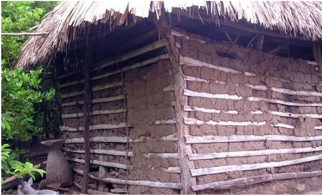
Figura 7. Técnica constructiva, Bahareque. Adaptado: página web 365 palabras. Bahareque (16 de enero del 2018)
