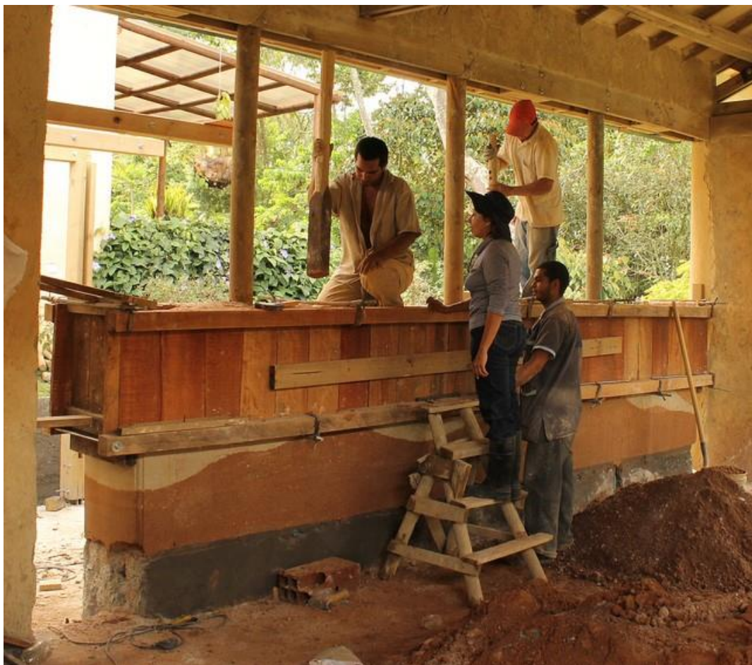
Figura 9. Muro de tapia en construcción. Adaptado: página web escala urbana. Casa Mila (16 de enero del 2018)
