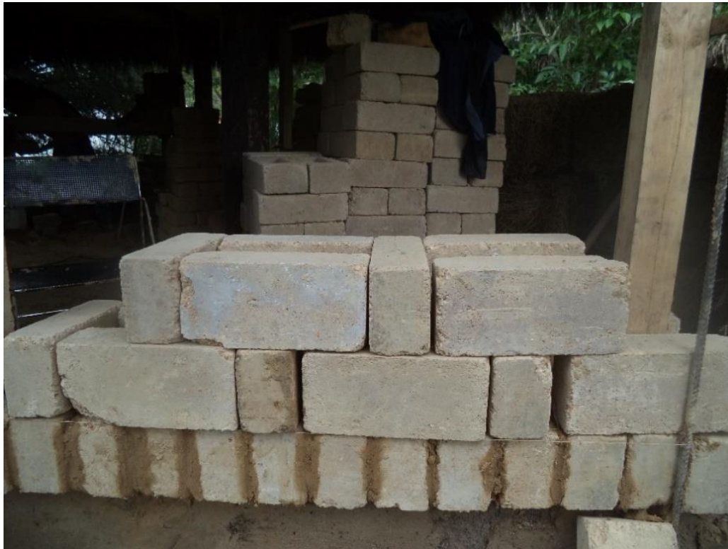
Figura 28. Muro en Bloque de tierra comprimida.
