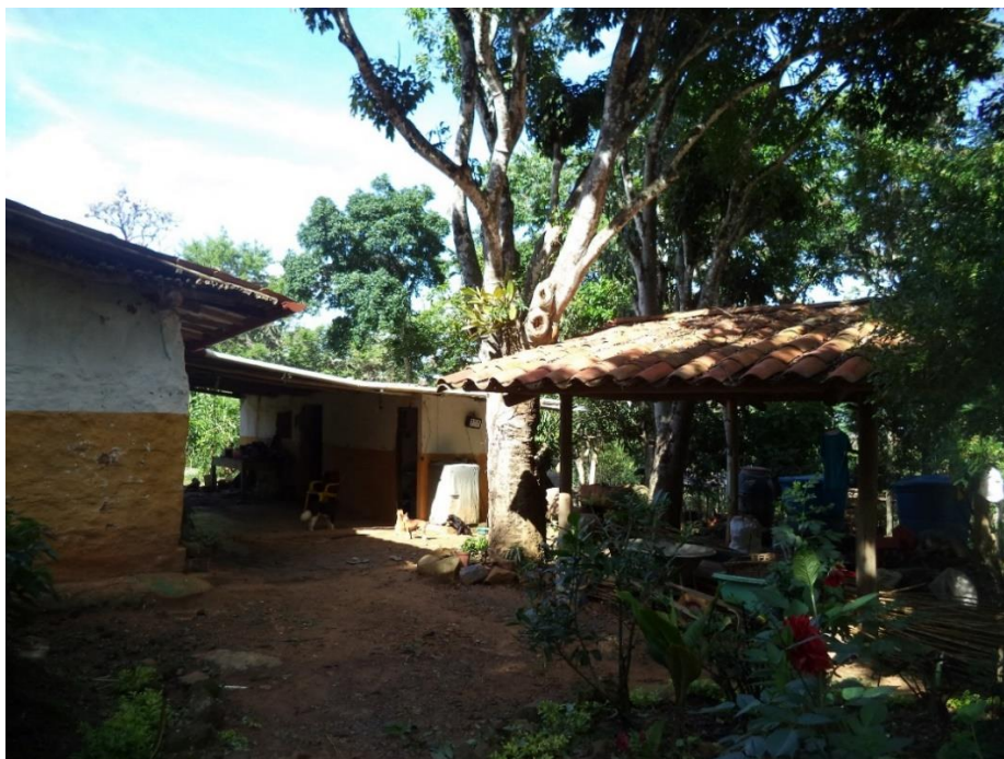
Figura 18. Ingreso a la vivienda.
