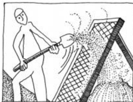
Figura 30. Tamizado manual de la tierra. Adaptado: técnicas de construcción con tierra
