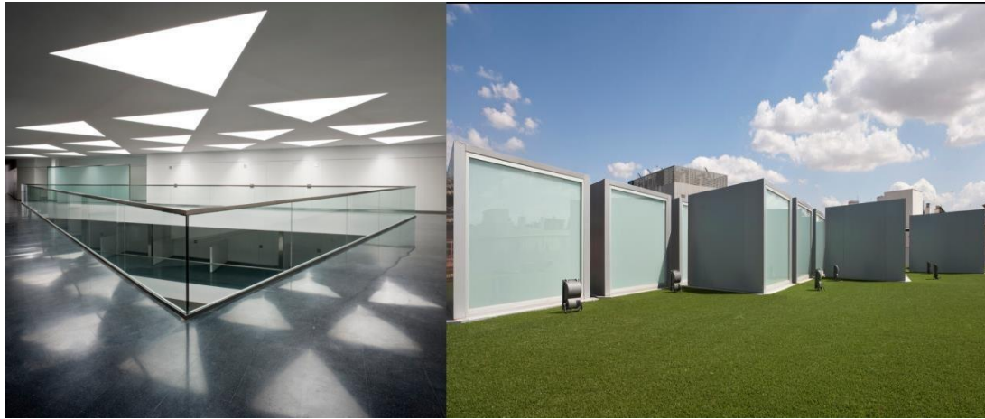
Figura 33. Fotografías exterior centro de salud Alamillo, funcionalidad de iluminación
