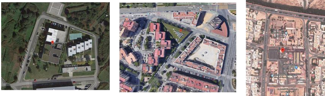
Figura 52. Ubicación satelital centros de salud, Muros, Alamillo y Ali Mohammed Fuente
