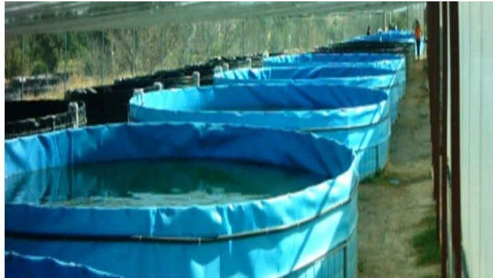
Figura 7. Estanque circulares en geomembrana.
