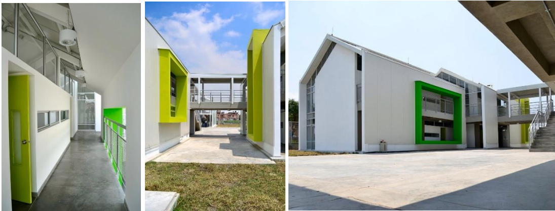
Figura 10. Jardín infantil El Caracol. Vistas de circulaciones interiores y exteriores. Vista espacio central
