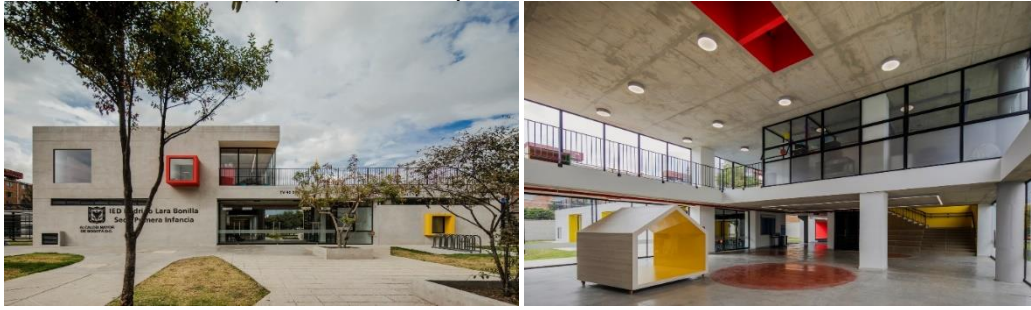
Figura 16. Vistas exterior e interior del edificio
