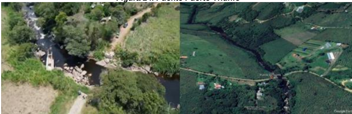
Figura 24. Puente Puerto Triunfo
