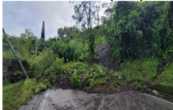
Figura 22. Deslizamientos de tierra a la altura de la Ruta Nacional del municipio de Moniquirá en ocasión de las lluvias del 18 y 19 de junio de 2024
