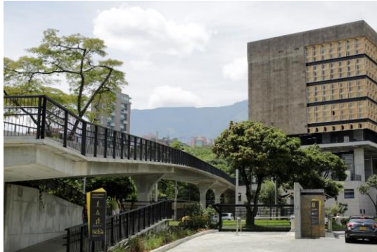
Ilustración 3 Puente peatonal Universidad EAFIT
