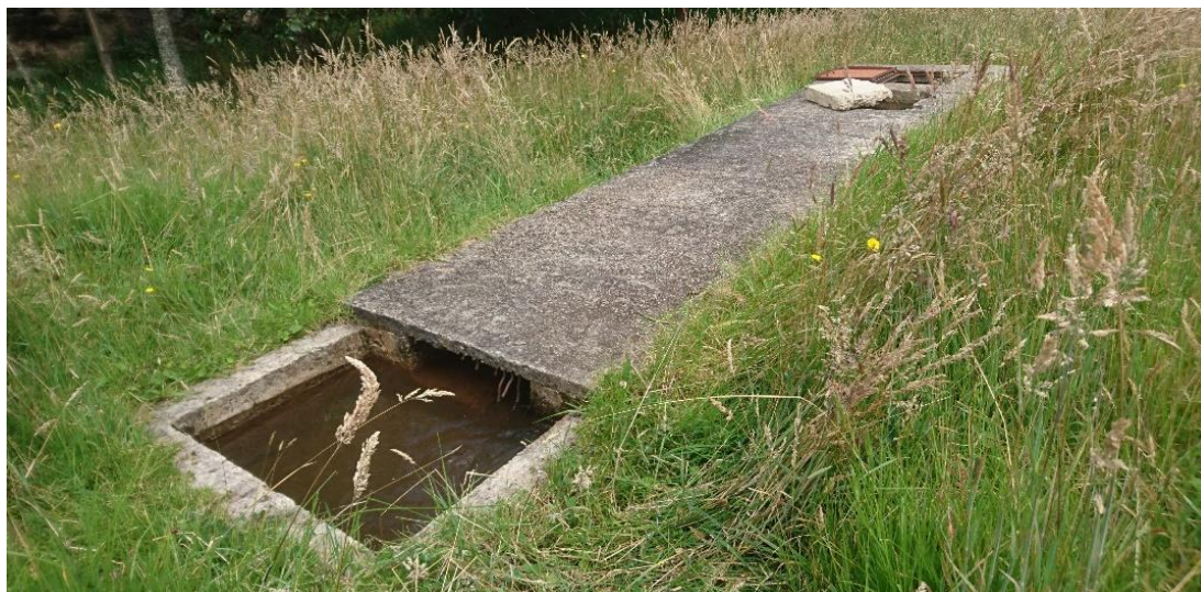
Imagen 6 Desarenador aguas abajo de la bocatoma
