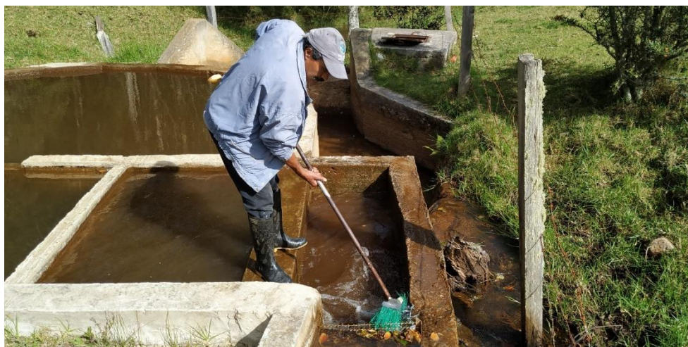
Imagen 7 Mantenimiento y limpieza técnica de infraestructura ACUAVARC
