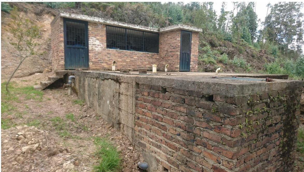
Imagen 10 Tanque de almacenamiento de acueducto ACUAVARC
