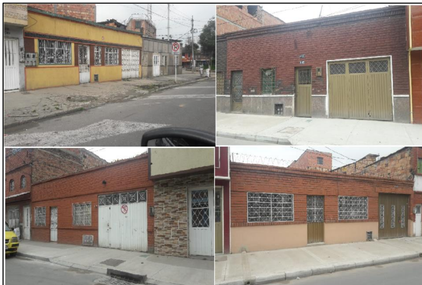
Fotografía 9: Vivienda Unifamiliar de una planta
