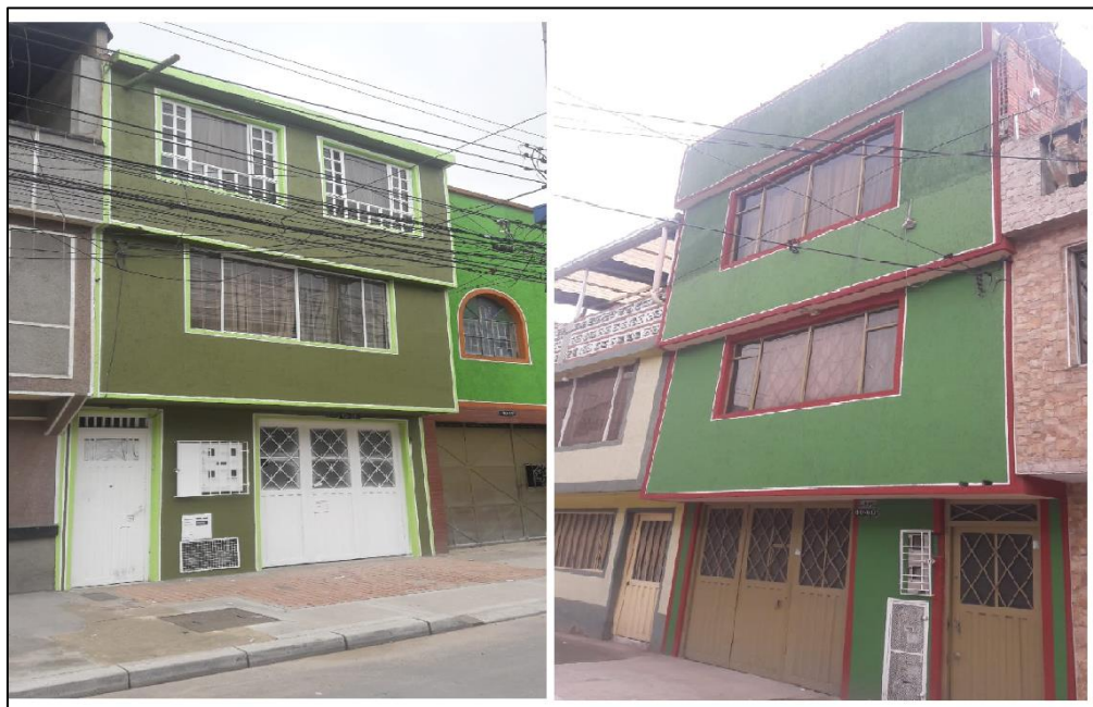
Fotografía 11. Vivienda multifamiliar de tres planta
