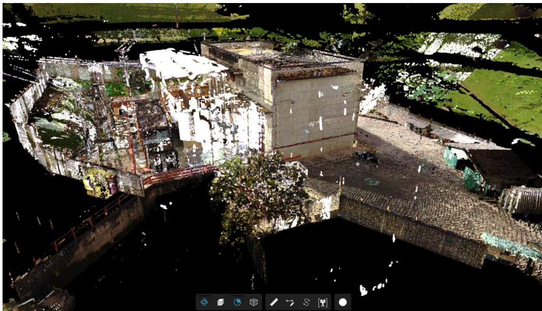
Figura 1. Captura de nube de puntos de casa de máquinas de Troneras
