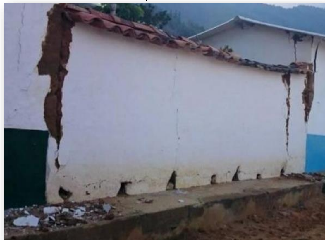
Daño en edificaciones de Betulia por sismo 2010 Fuente: informe del sismo - RSNC
