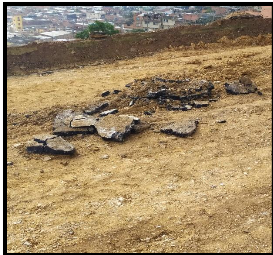
Fotografía 12 Demolición pavimento de asfalto Fuente: Autor
