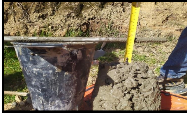
Fotografía 28 Asentamiento de 3 pulgadas Concreto de Losa Fuente: Autor
