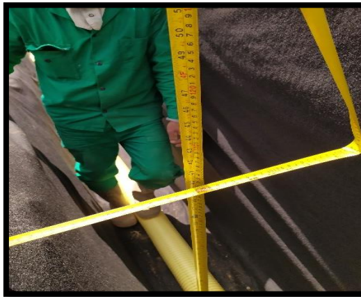
Fotografía 17 Verificación de profundidad estructura de drenaje.
