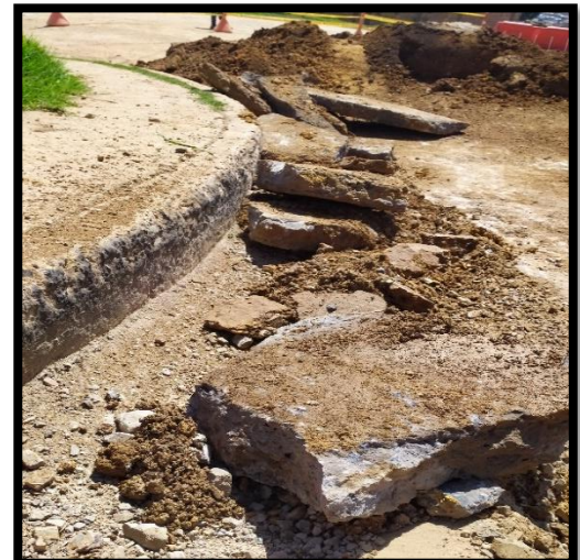
Fotografía 13 Demolición cuneta Fuente: Autor
