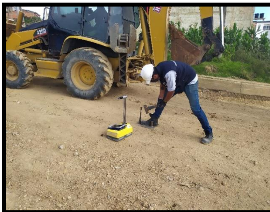
Fotografía 15 Ensayo de densidad del suelo. Fuente: Autor
