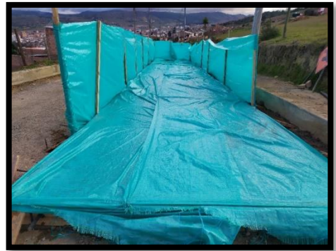
Fotografía 46 Protección de la Estructura Contra las Condiciones Atmosféricas Fuente: Autor
