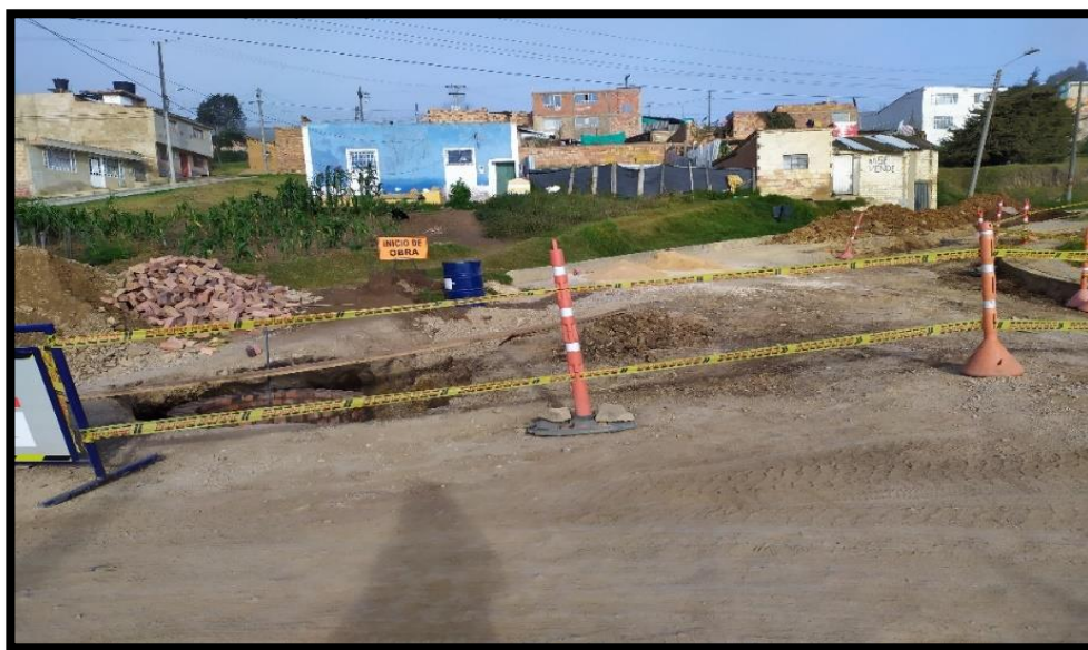
Fotografía 1 Inicio de la obra. Renovación de la red de alcantarillado, barrio San Lázaro. Fuente: Autor
