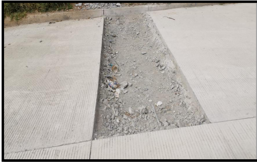
Fotografía 34 Demolición de Losa
