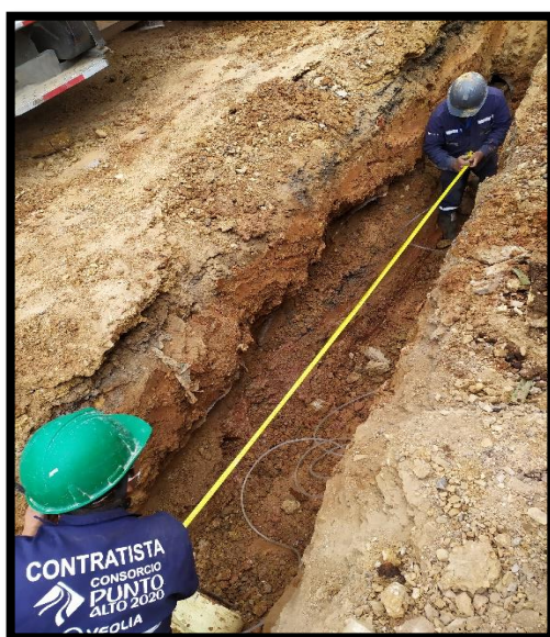
Fotografía 3 Verificación de Pendiente, con Manguera de Nivel.
