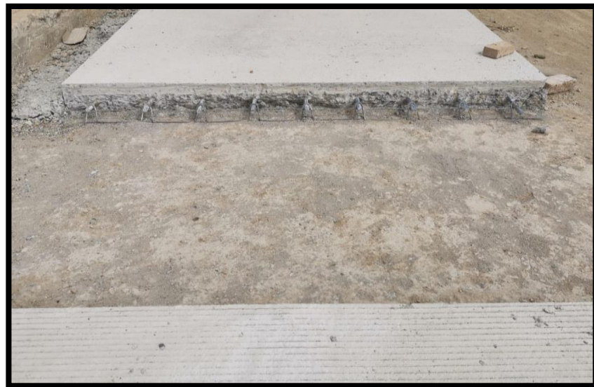
Fotografía 35 Demolición Segunda Losa
