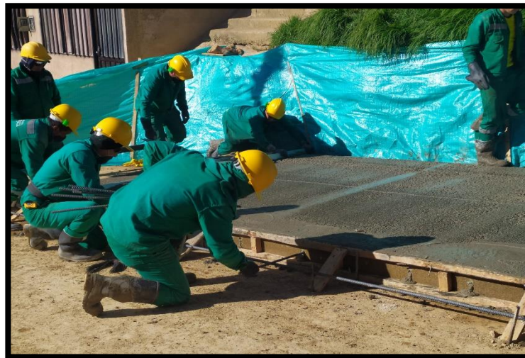
Fotografía 39 Ubicación y colocación de barras de amarre en estado fresco del concreto Fuente: Autor
