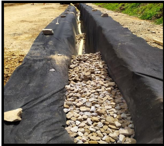
Fotografía 18 Estructura de drenaje. Fuente: Autor
