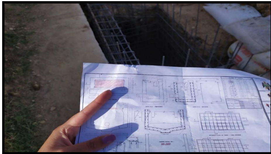
Fotografía 20 Verificación de Diseño Sumideros Fuente: Autor
