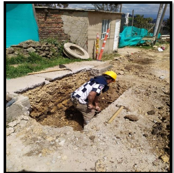
Fotografía 11 Excavación sumideros Fuente: Autor
