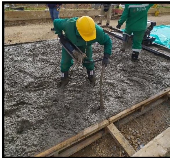
Fotografía 24 . Vibrado del Concreto
