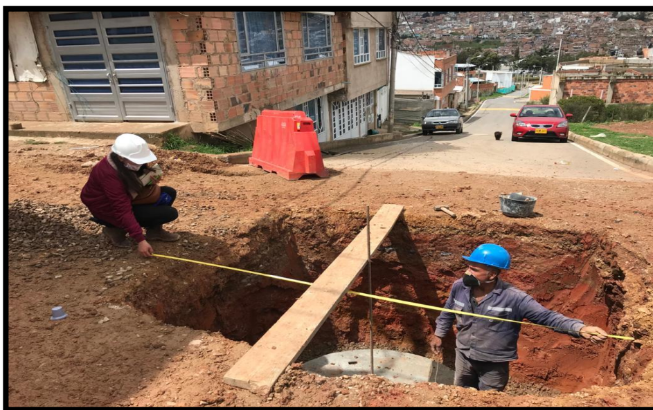
Fotografía 8 Actividad de toma de cantidades Fuente: Autor
