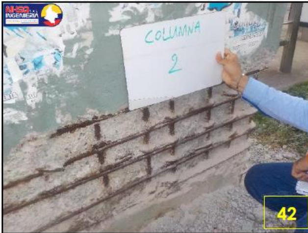
Imagen 6. Verificación de refuerzos columnas
