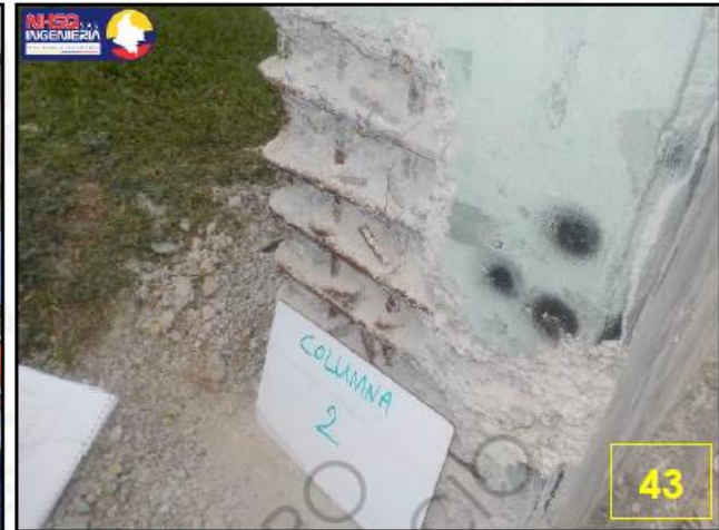
Imagen 6. Verificación de refuerzos columnas
