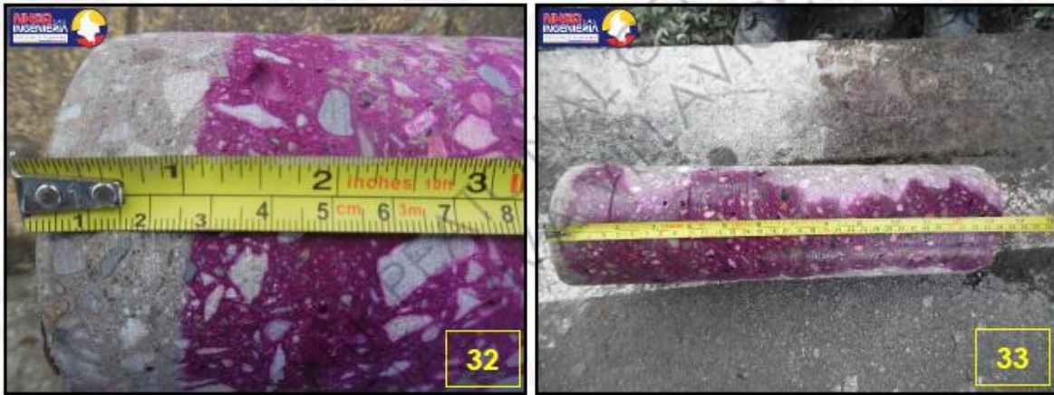
Imagen 11. Ensayo de fenolftaleína y medición del espesor de carbonatación en muros.
