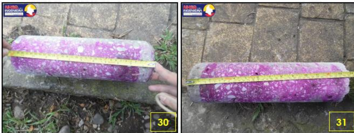
Imagen 10. Ensayo de fenolftaleína y medición del espesor de carbonatación en columnas
