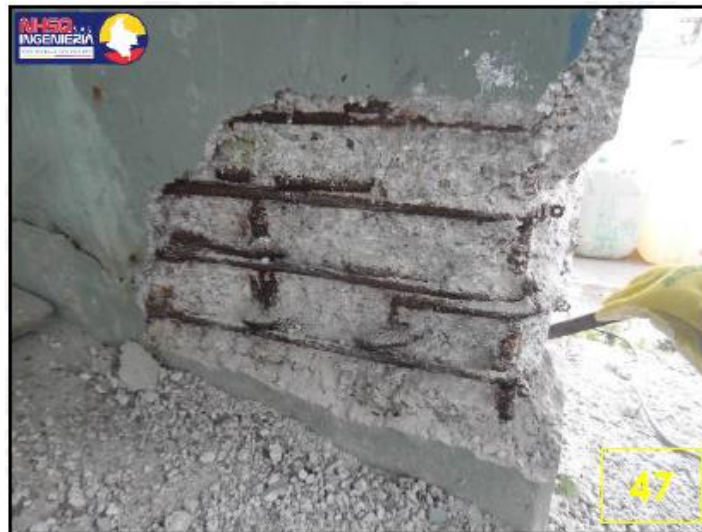
Imagen 3. Evidencia del refuerzo existente del muro pantalla
