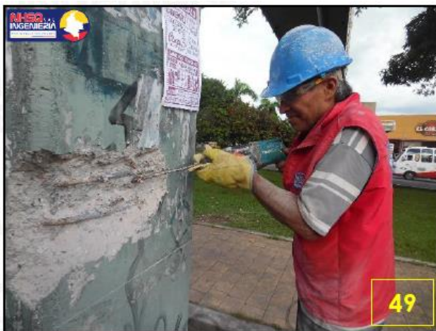
Imagen 4. Elaboración de regatas columnas.
