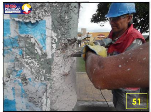
Imagen 4. Elaboración de regatas columnas.
