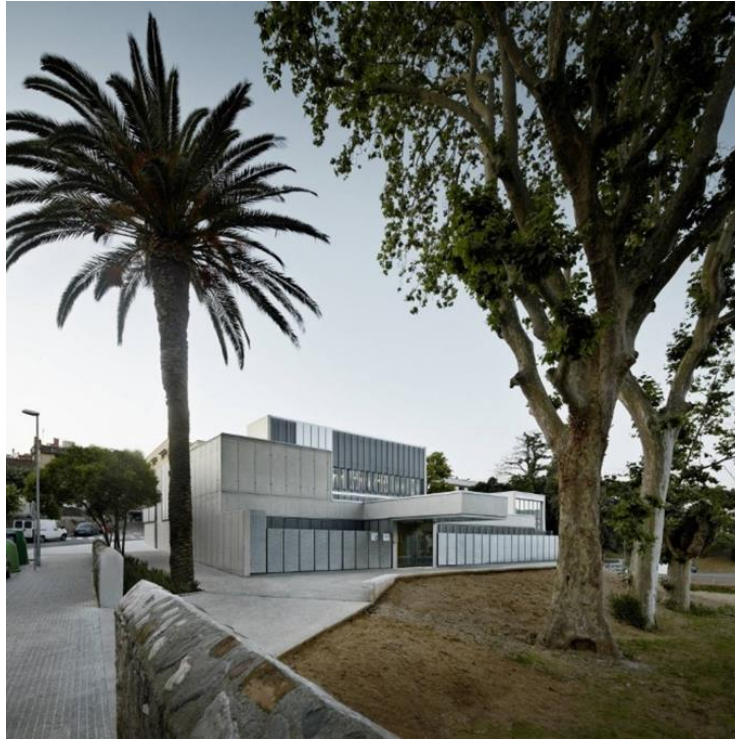
Figura 25. Fotografía exterior del centri de salud la garriga
