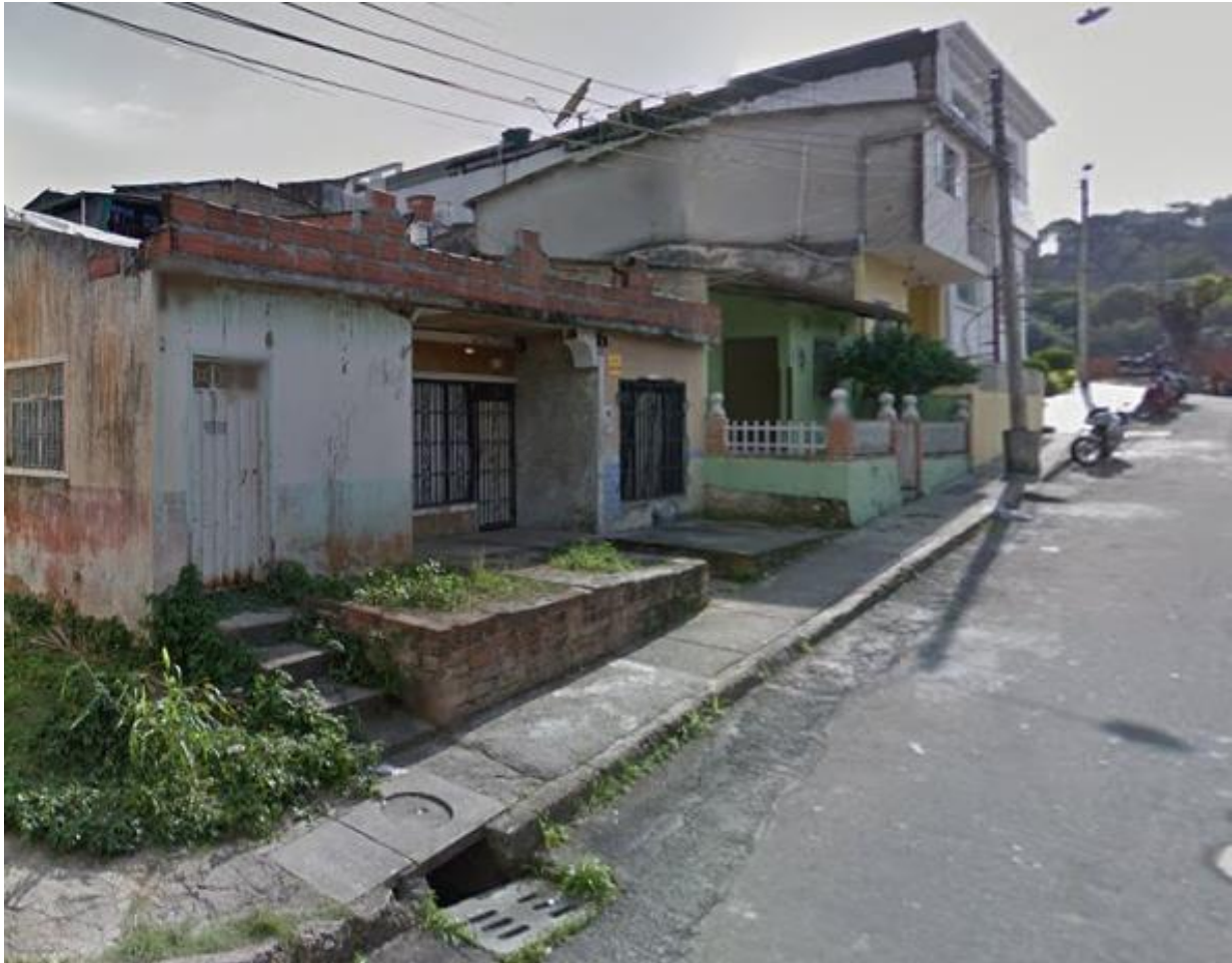
Figura 141 fotografía de edificios colindantes
