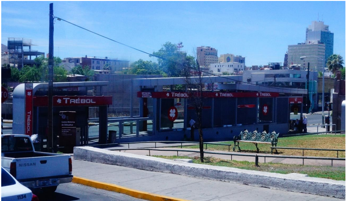
Fotografía 11. Modelo estaciones Troncal 1 sistema MetroBús.
