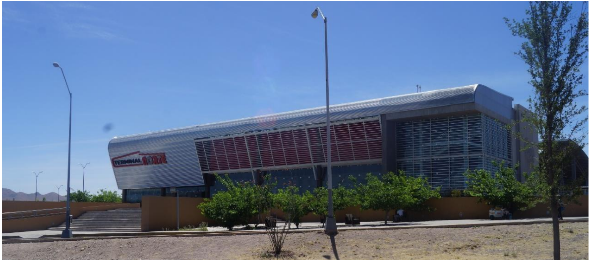
Fotografía 8. Terminal norte sistema MetroBús (antiguo ViveBús).
