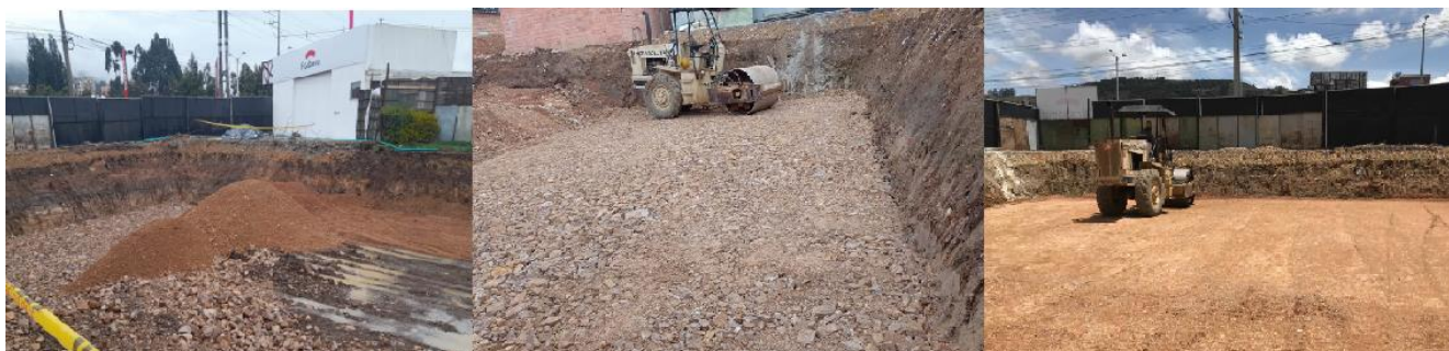
Figura 8. Relleno con piedra rajón, sub-base granular y compactación del material
