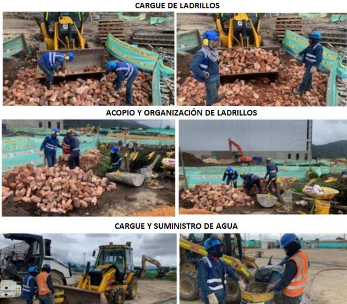
Figura 18. Trasiego de material en obra
