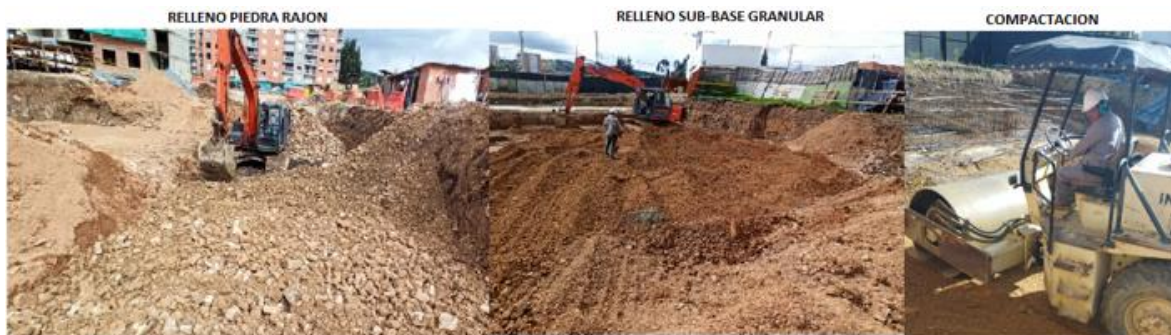
Figura 9. Suministro, extensión y compactación de piedra rajón y sub-base granular etapa 2
