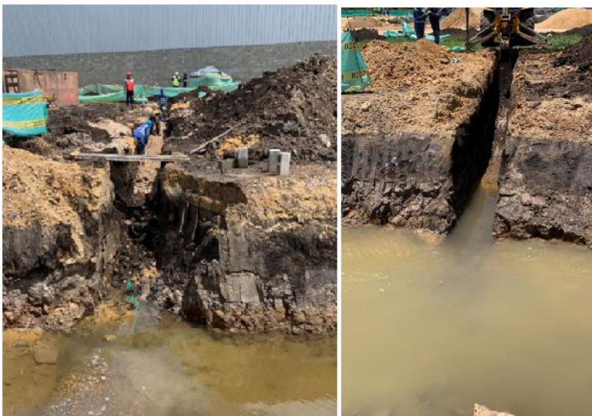
Figura 17. Excavación en el tramo del box culvert
