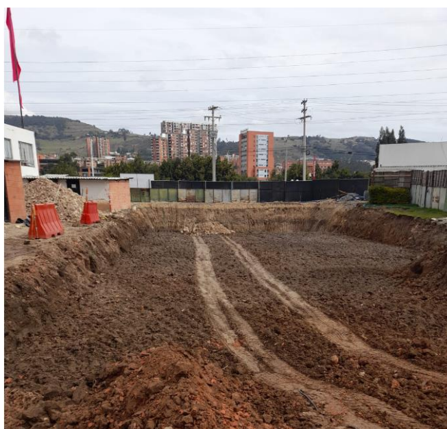
Figura 4. Terreno de la torre 2 de apartamentos
