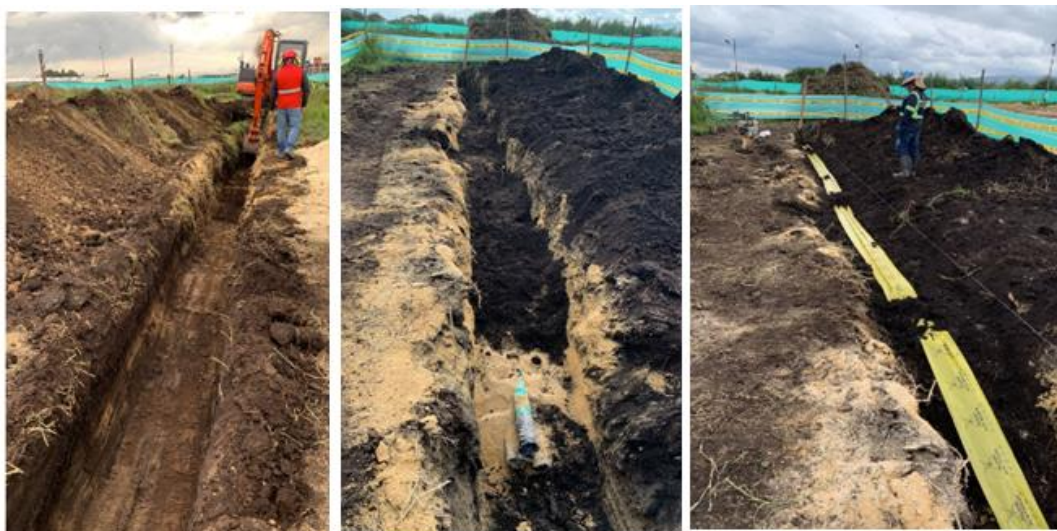
Figura 16. Actividades de excavación para canalización de tubería
