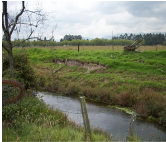
Figura 37. Derrumbes en los bordes del cauce del río Neusa en Nemocón. (IGAC, 2013)
