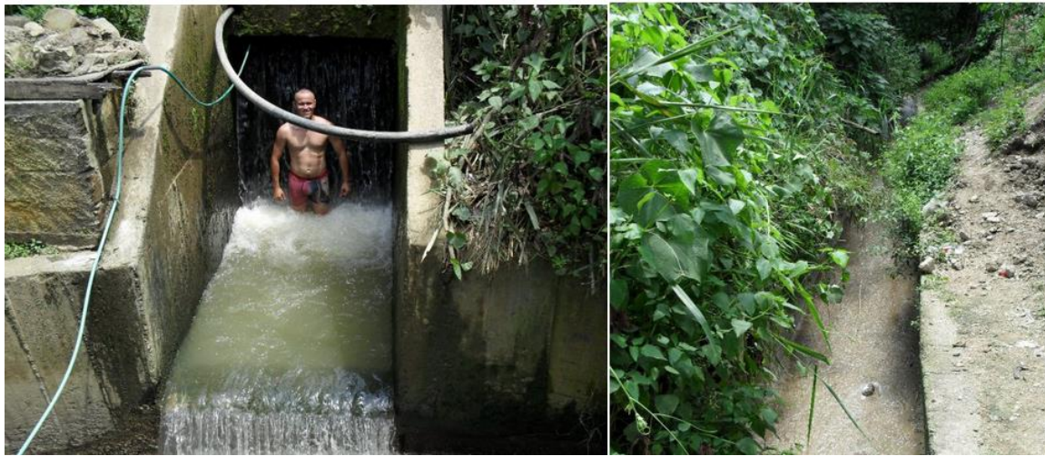
Figura 23. Fotografía de la infraestructura para la conducción del agua.
