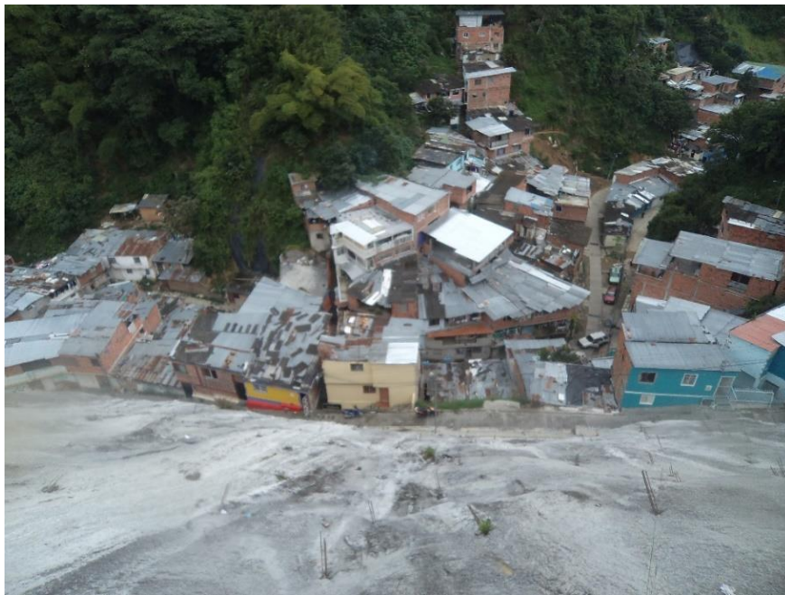
Figura 29. Fotografía barrio Albania. Viviendas.
