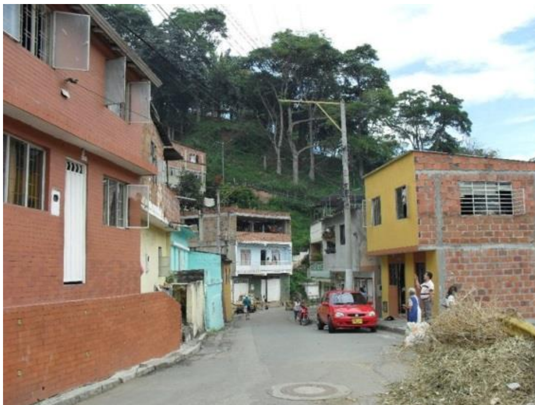
Figura 18. Reconocimiento barrio Albania. Vista sur – norte al parque Morrónico.
