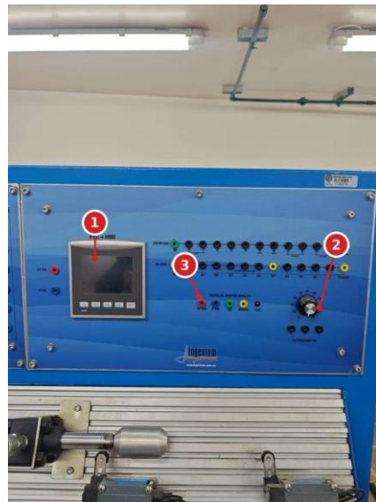
Figura E.8 — Tablero PLC + HMI Unitronics V350 verificado en funcionamiento.
