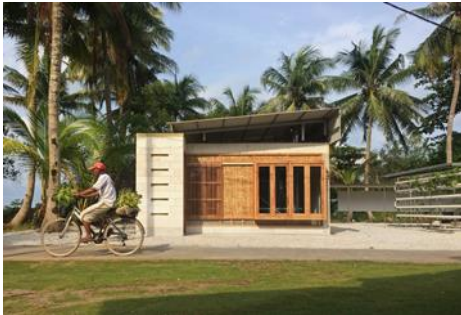
IMÁGEN 9 Fachada frontal Casa Ampliable
