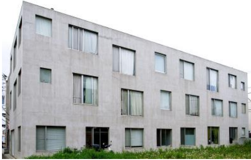
IMÁGEN 8 Fachada apartamento Funabashi
