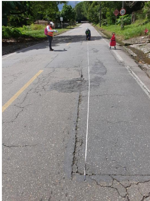
Figura 12.2 Parche (PCH), T3; P70; Sev. A Fuente: [22]
