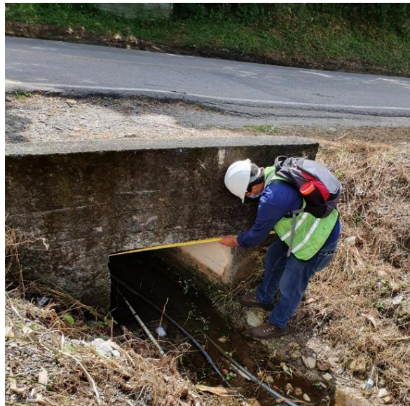
Figura 11.2 Figura. Inspección visual de estructuras de drenaje Fuente: [22]
