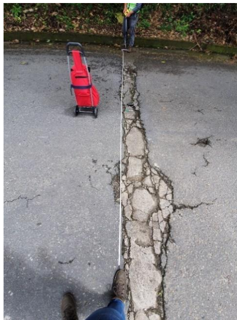
Figura 12.8 Fisuras en Juntas de Construcción Transversal (FCT), P448; Sev. A; K1+449.74 Fuente: [22]
