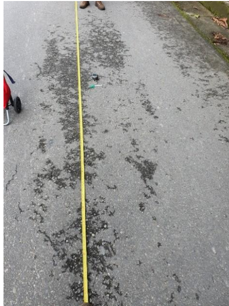
Figura 12.18 Pulimentos de agregados (PU), P414; Sev. M; K1+371.76 Fuente: [22]
