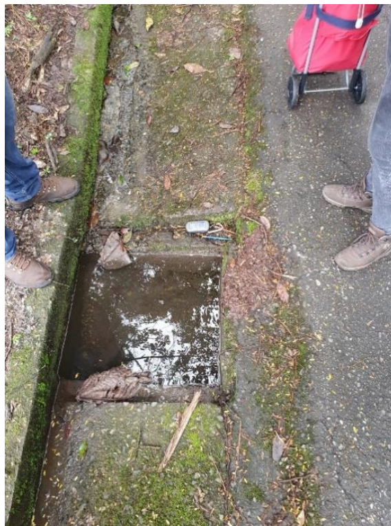
Figura 11.1 Reconocimiento previo de las estructuras de drenaje Fuente: [22]
