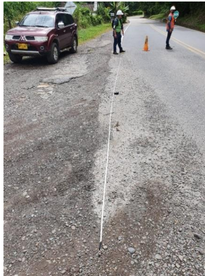
Figura 12.19 Cabezas Duras (CD), P223; Sev. M; K0+658.74 Fuente: [22]
