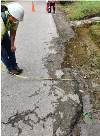
Figura 12.16 Desgaste Superficial (DSU), P193; Sev. A; K0+584.25 Fuente: [22]
