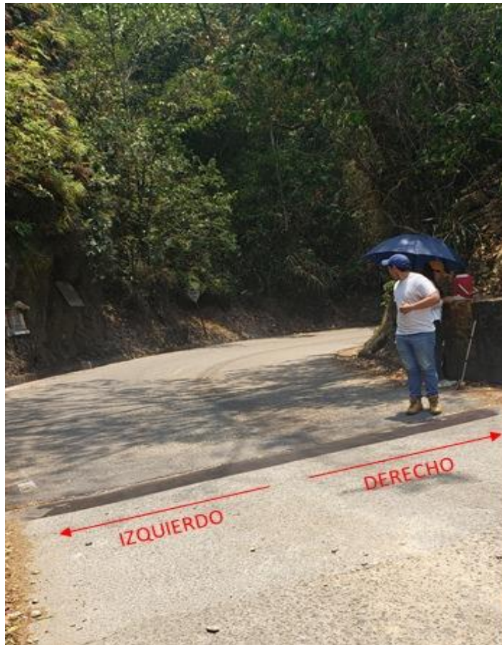
Figura 9.2 Punto de inicio: Inspección visual del tramo de estudio Fuente: [22]
