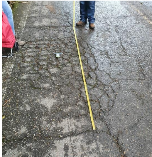
Figura 12.3 Piel de Cocodrilo (PC), T1; P15; Sev. A Fuente: [22]
