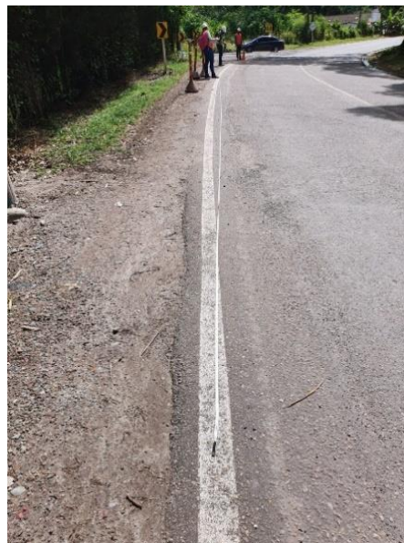
Figura 12.13 Abultamientos (AB), P230; Sev. M; K0+689.42 Fuente: [22]
