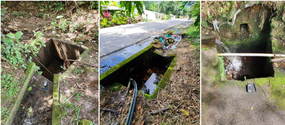
Figura 12.25 Estructuras de drenaje complementarias, Sumideros Fuente: [22]
